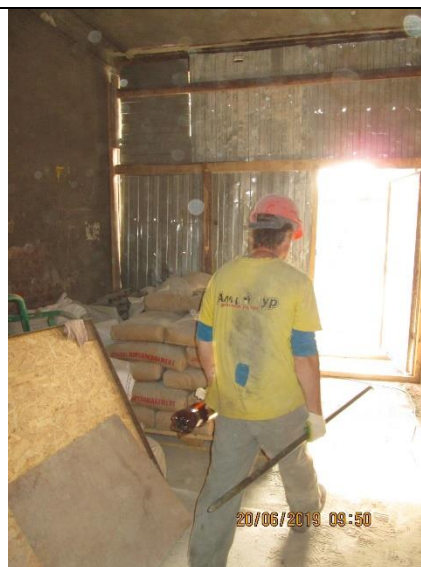
Фото 14. Вход со двора в помещение 5-Н, входящее в состав Объекта оценки.
