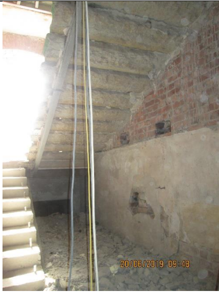
Фото 15. Помещение 5-Н (предположительно), входящее в состав Объекта оценки.
