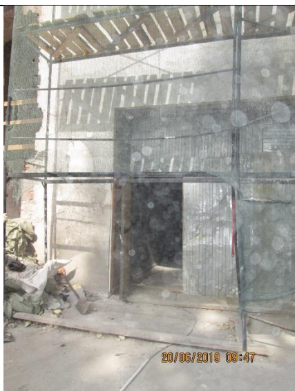
Фото 13. Вход со двора в помещение 5-Н, входящее в состав Объекта оценки.
