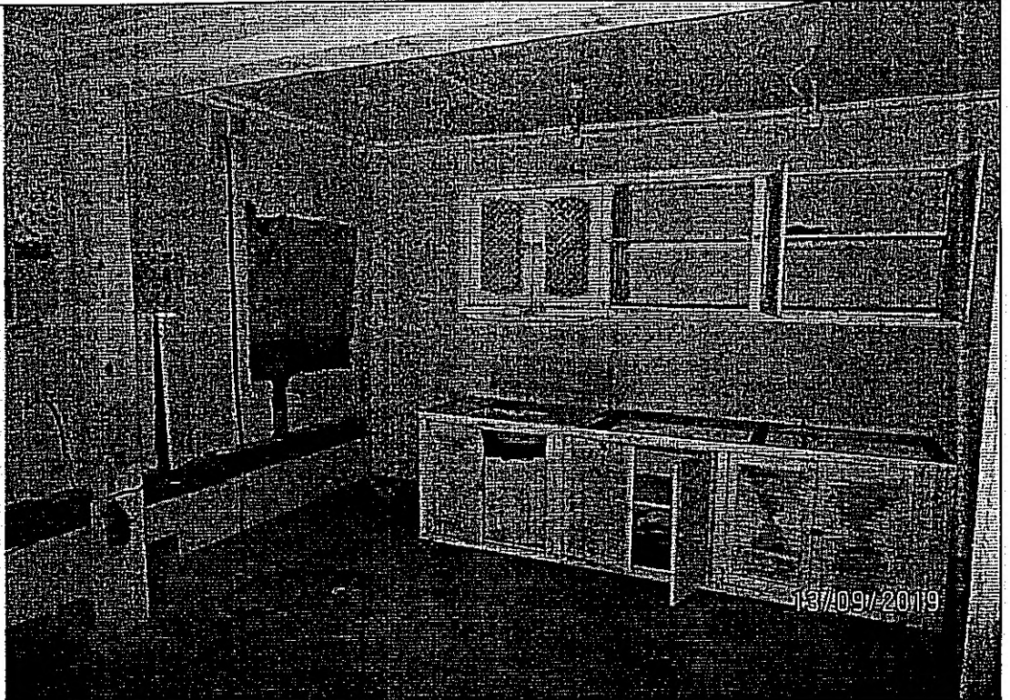
Описание: Вид на ч.п. 2 Объекта
