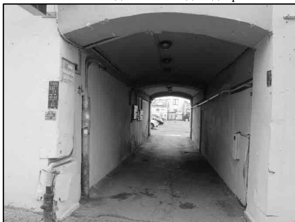
Фото 9. Вид арки, ведущей во двор
