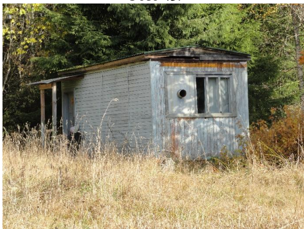
Фото 45. Здание КПП (не входит в состав Объекта оценки)
