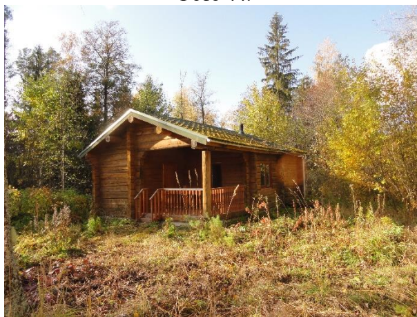
Фото 46. Здание бани (не входит в состав Объекта оценки)
