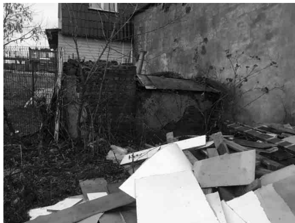
Фото 14 Глухая стена здания
