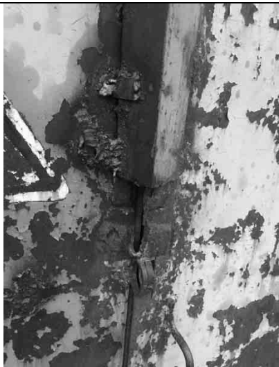
Фото 13 Вход в здание
