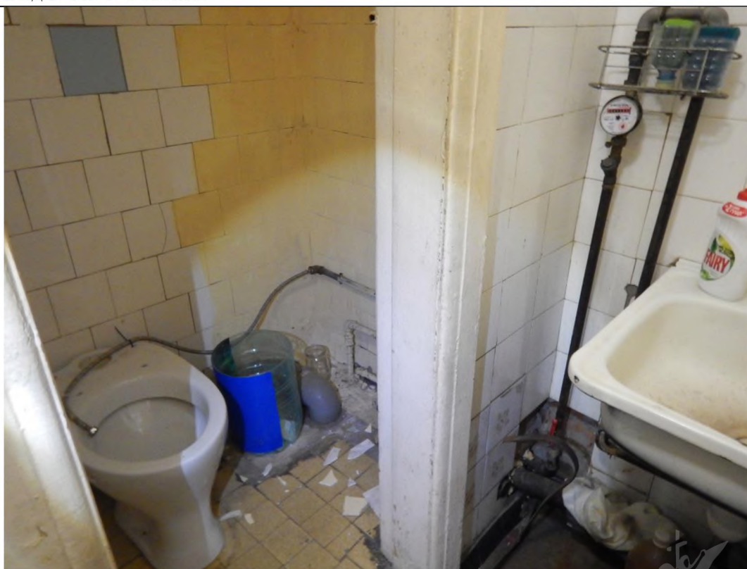
Описание: Вид в ч.п 4 и 5 Объекта.
