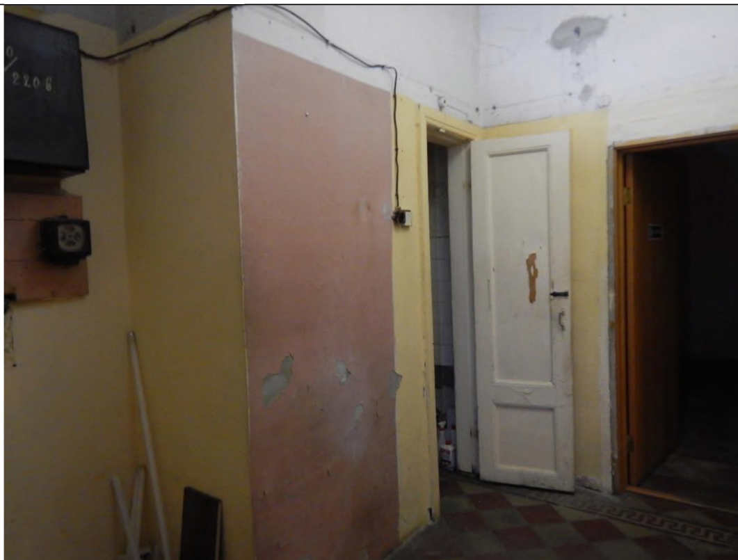
Описание: Вид в ч.п. 3 Объекта.
