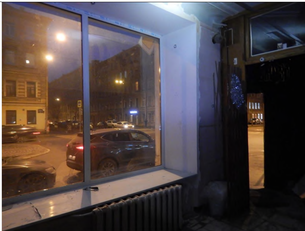
Описание: Вид на ч.п. 1 Объекта.
