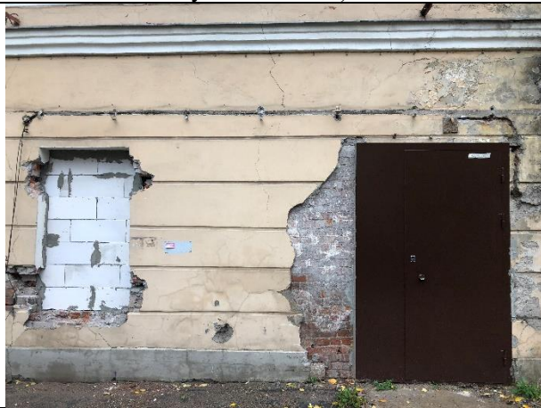
Фото 9. Состояние входов, окон, фасада здания
