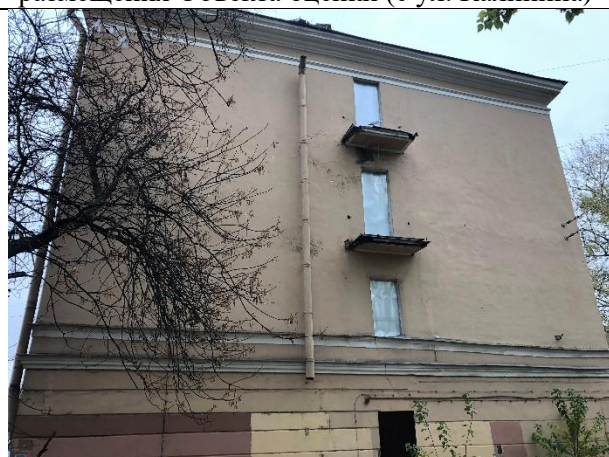
Фото 3. Вид на здание размещения Объекта оценки с торца
