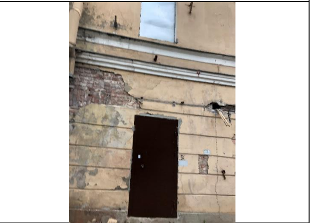
Фото 10. Состояние входов, окон, фасада здания
