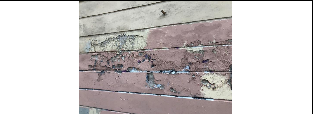
Фото 11. Состояние фасада здания
