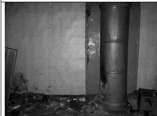
Фото 15. Внутреннее состояние здания
