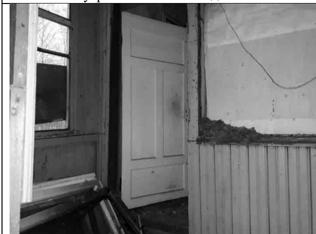
Фото 17. Внутреннее состояние здания
