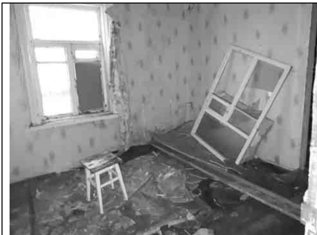
Фото 19. Внутреннее состояние здания
