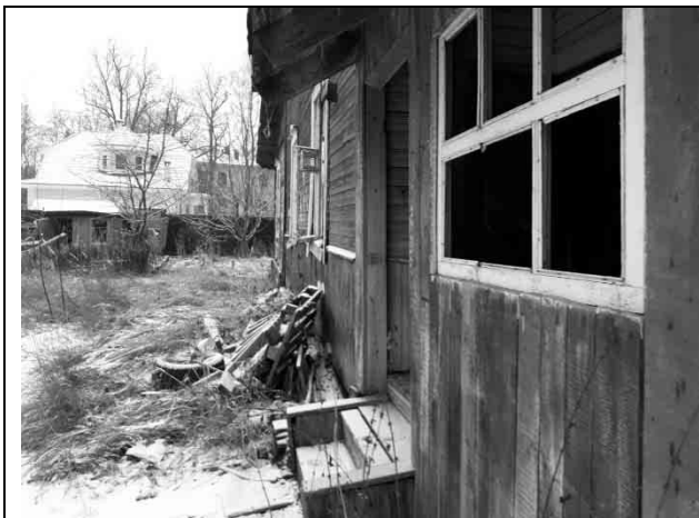
Фото 13. Доступ в здание
