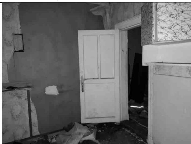
Фото 16. Внутреннее состояние здания
