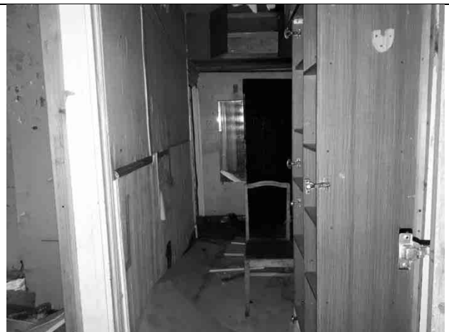
Фото 20. Внутреннее состояние здания
