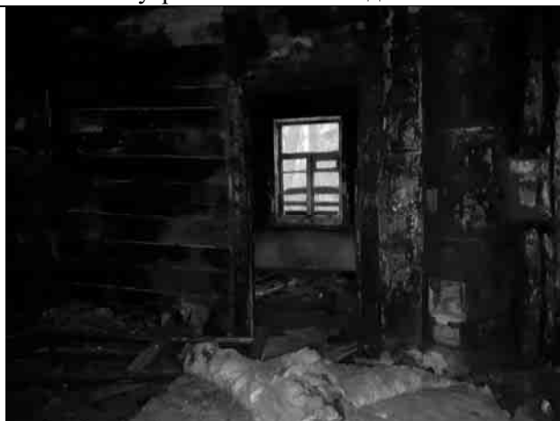
Фото 18. Внутреннее состояние здания
