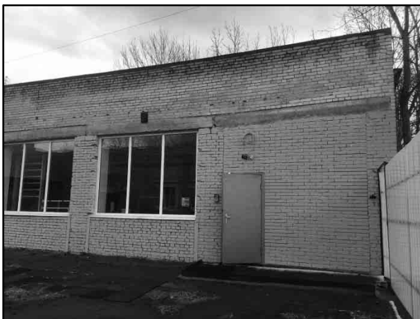
Фото 5. Вид здания, в котором расположен Объект оценки, со двора
