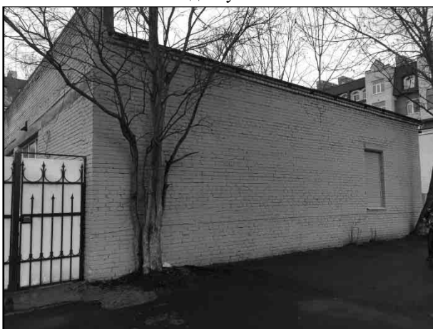
Фото 3. Вид здания, в котором расположен Объект оценки, со двора
