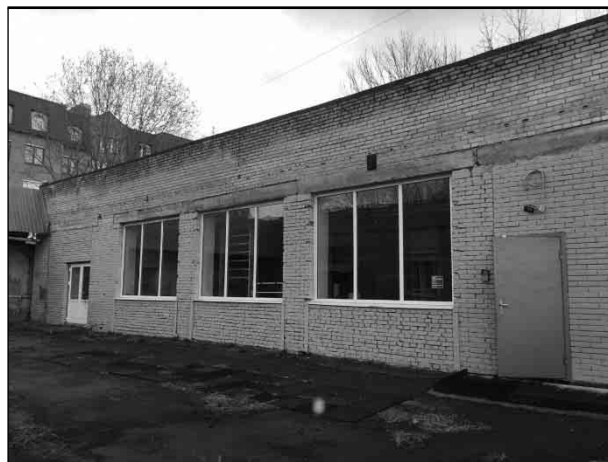
Фото 6. Вид здания, в котором расположен Объект оценки, со двора
