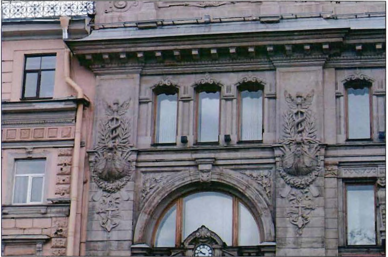
2. Лицевой фасад по Невскому проспекту. Фрагмент.
