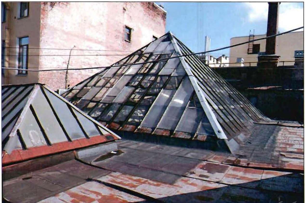
6. Общий вид кровли. Фрагмент. Световые фонари.
