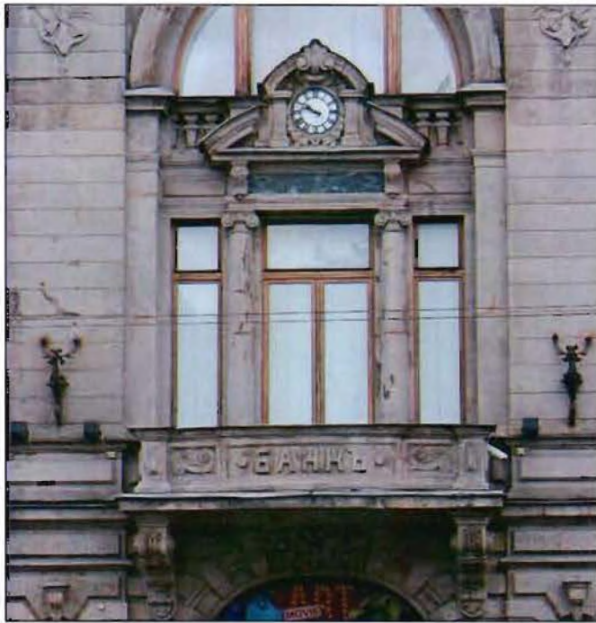
4. Лицевой фасад по Невскому проспекту. Фрагмент.
