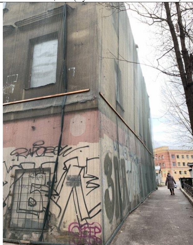
Фото 4. Вид на здание размещения Объекта оценки с торца
