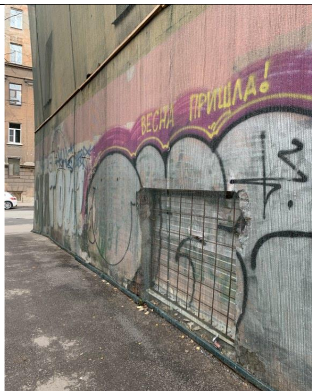
Фото 8. Отдельный вход в пом. 4-Н с торца здания
