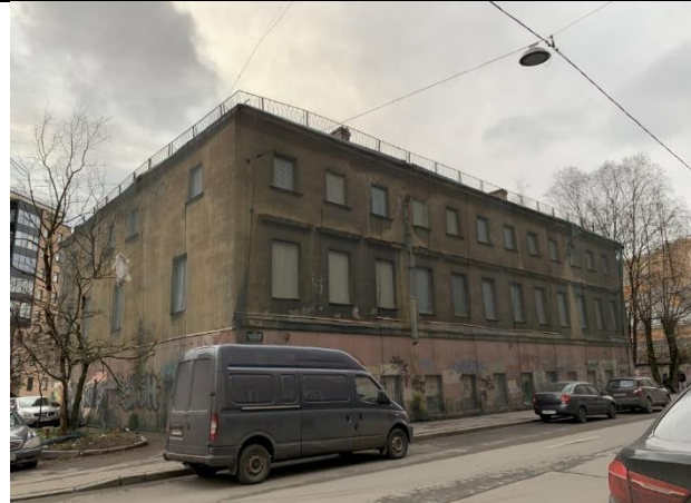
Фото 2. Вид на фасадную часть здания размещения Объекта оценки (с ул. Константина Заслонова)
