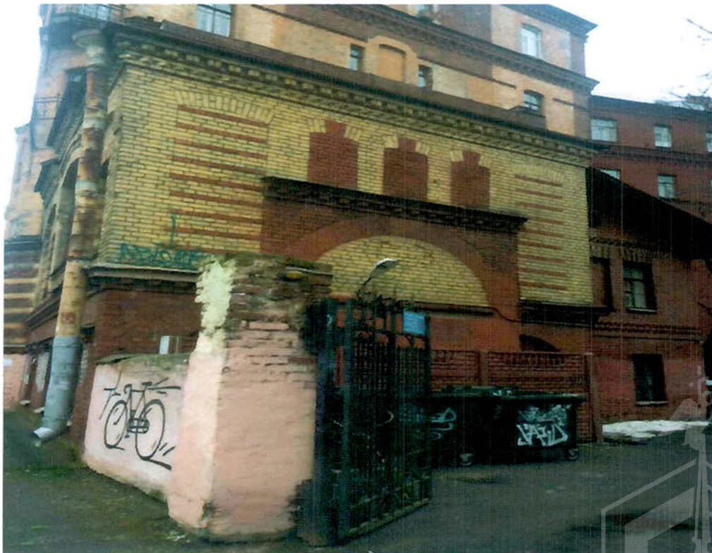
12. Общий вид (восточный фасад).
