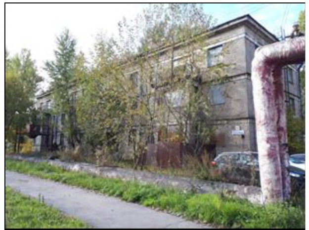
Фото 2. Вид жилого дома с ул. Севастьянова
