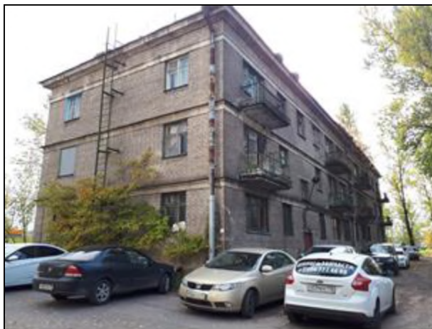
Фото 3. Вид жилого дома со двора
