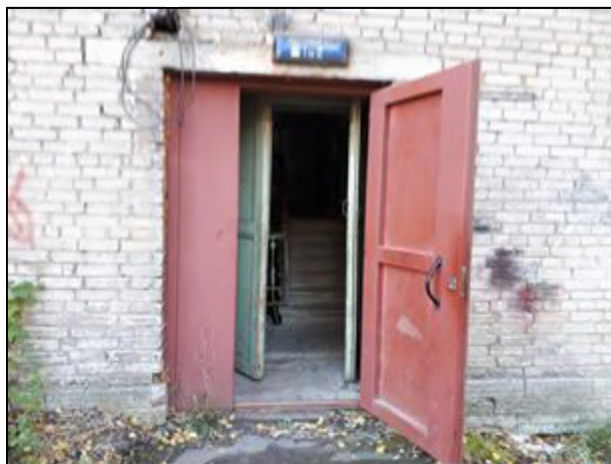
Фото 11. Общий вход со двора
