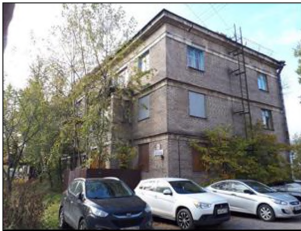
Фото 1. Вид жилого дома с ул. Севастьянова
