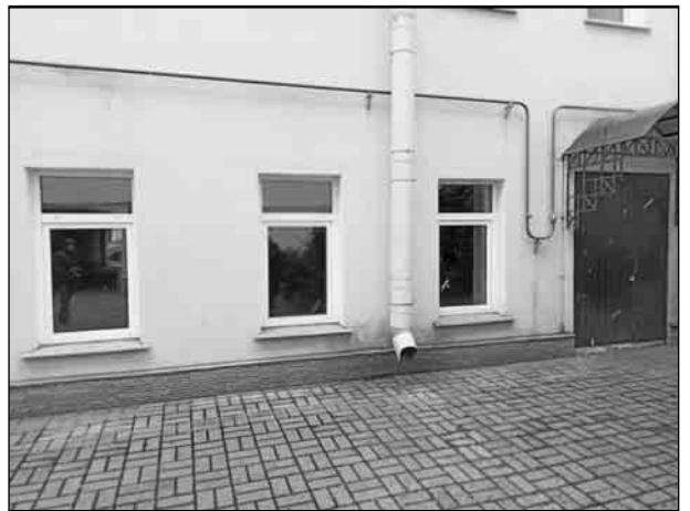
Фото 8. Вход в пом. 3-Н и окна – во двор
