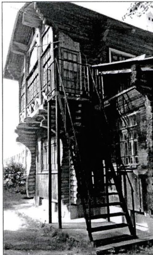
2. Северо-восточный фасад здания. Фрагмент, пожарная лестница.
