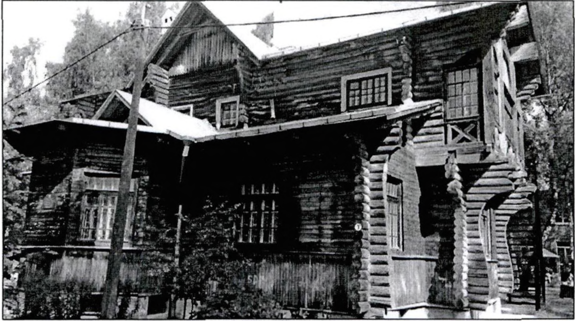
1. Общий вид с юго-восточного фасада здания.
