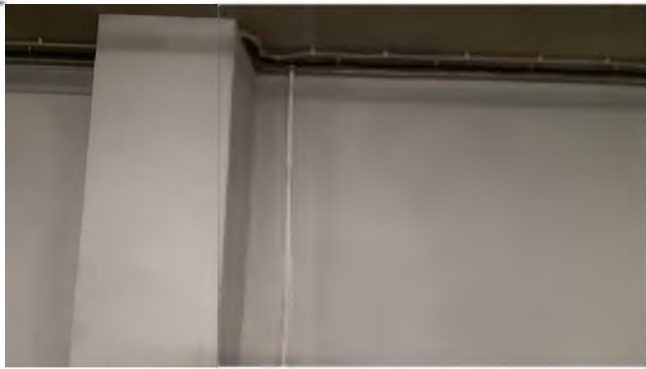
Фото 29. Типовое состояние помещения 19-Н (3 этаж). Проведен водопровод.
