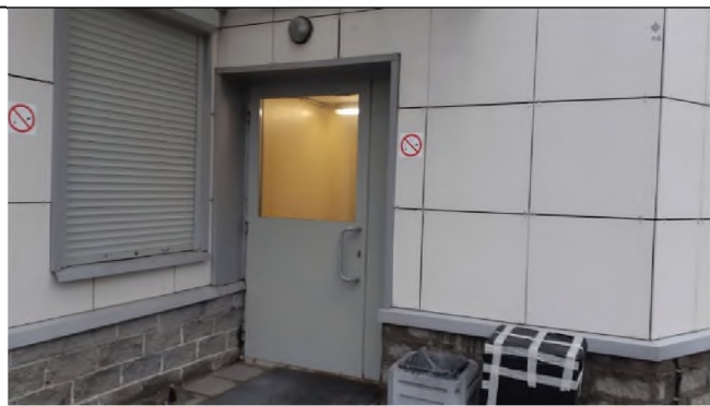
Фото 34. Общий вход в помещение 19-Н с ул. Осипенко.
