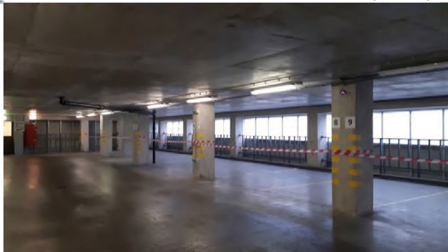
Фото 21. Типовое состояние помещения 19-Н (3 этаж).
