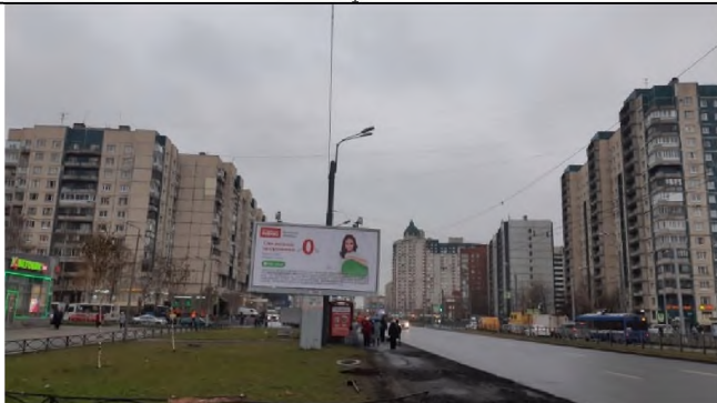
Фото 5. Окружение Объекта оценки.
