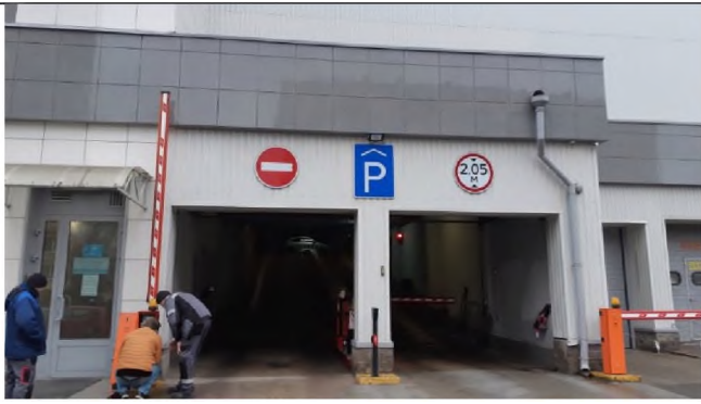
Фото 9. Въезд на территорию парковки (отдельный въезд в пом. 19-Н).
