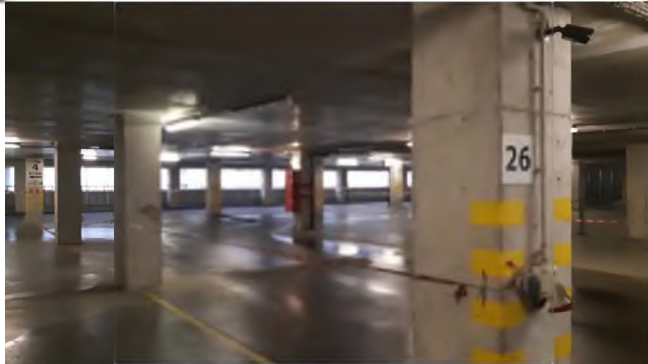
Фото 19. Типовое состояние помещения 19-Н (3 этаж).
