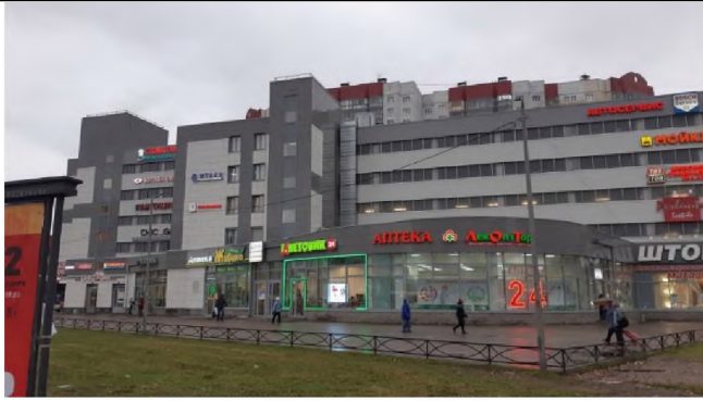
Фото 1. Вид на здание размещения объекта оценки с пр. Косыгина.
