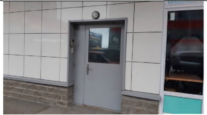
Фото 36. Общий вход в помещение 19-Н с дворовой территории.
