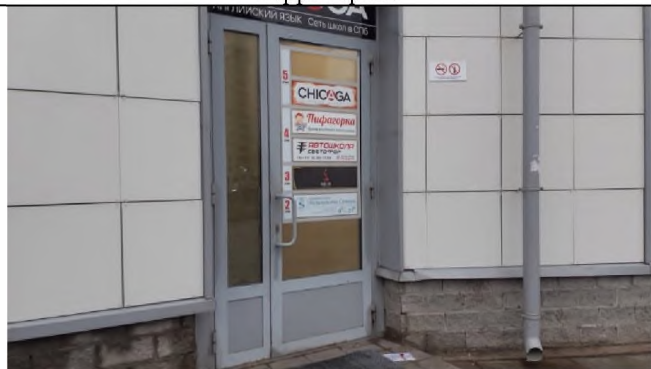
Фото 37. Общий вход в помещение 19-Н с пр. Косыгина.
