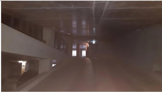
Фото 13. Типовое состояние помещения 19-Н (проезд между этажами)
