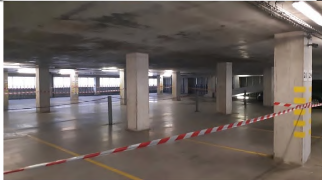
Фото 20. Типовое состояние помещения 19-Н (3 этаж).
