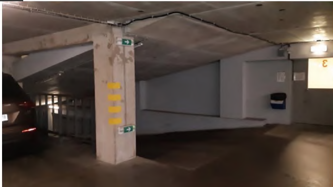
Фото 23. Типовое состояние помещения 19-Н (проезд между этажами)
