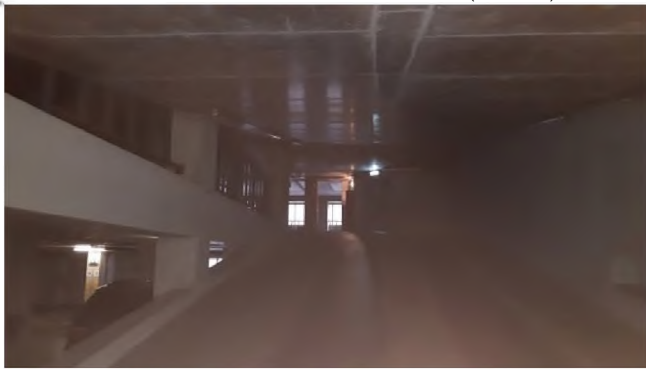
Фото 13. Типовое состояние помещения 19-Н (проезд между этажами)
