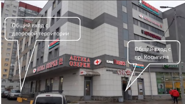
Фото 3. Вид на здание размещения объекта оценки с пр. Косыгина.
