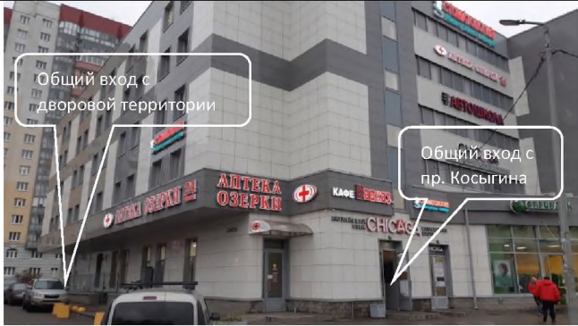
Фото 3. Вид на здание размещения объекта оценки с пр. Косыгина.
