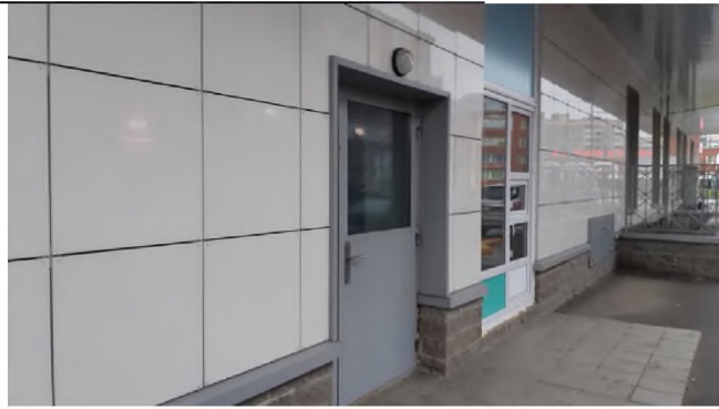
Фото 35. Общий вход в помещение 19-Н с дворовой территории.
