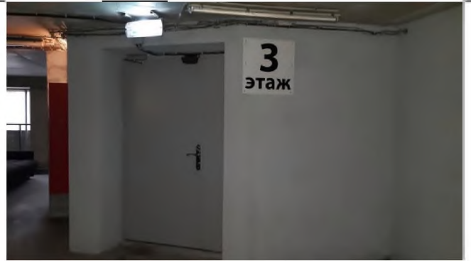
Фото 14. Запасной выход на лестничную клетку дверь на лестничную клетку общего входа с пр. Косыгина).
