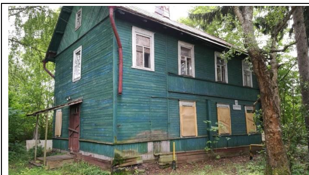
Фото 11. Общий вид здания.
