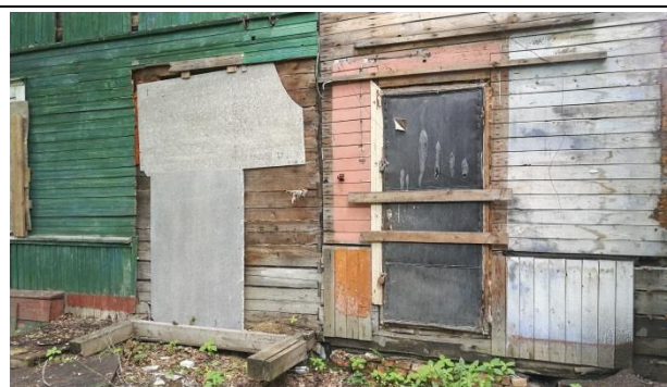
Фото 16. Вход в здание.
