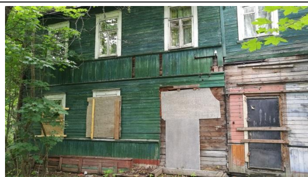
Фото 14. Окна и вход в здание.
