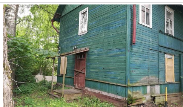
Фото 12. Окна и вход в здание.
