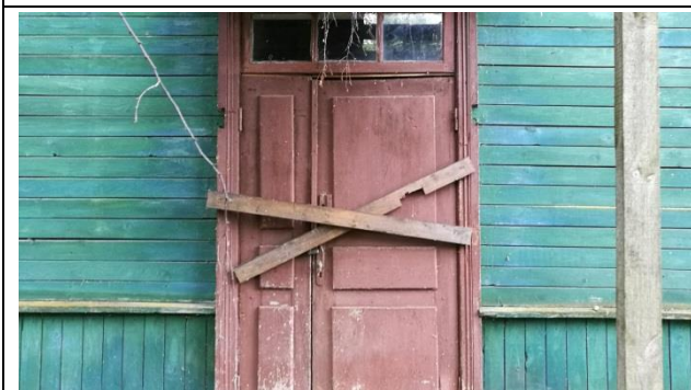
Фото 15. Вход в здание.
