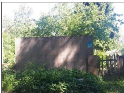
Фото 1. Бетонное ограждение части территории со стороны въезда
