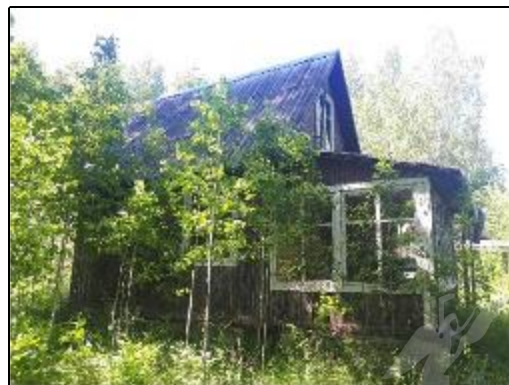
Фото 105. Общее состояние деревянных построек на участке
