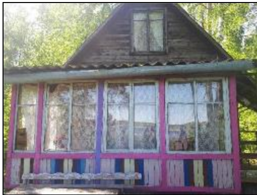
Фото 108. Общее состояние деревянных построек на участке
