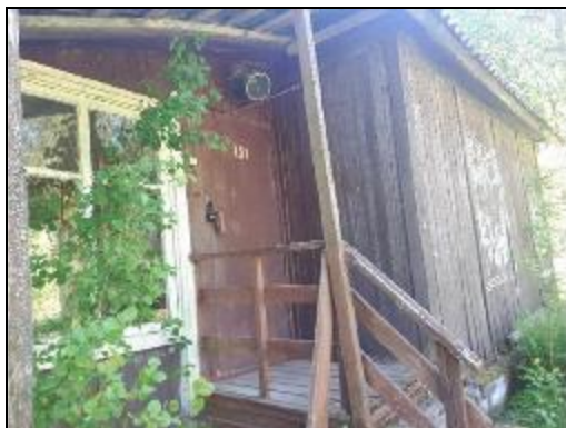
Фото 102. Общее состояние деревянных построек на участке
