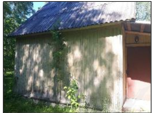
Фото 97. Общее состояние деревянных построек на участке
