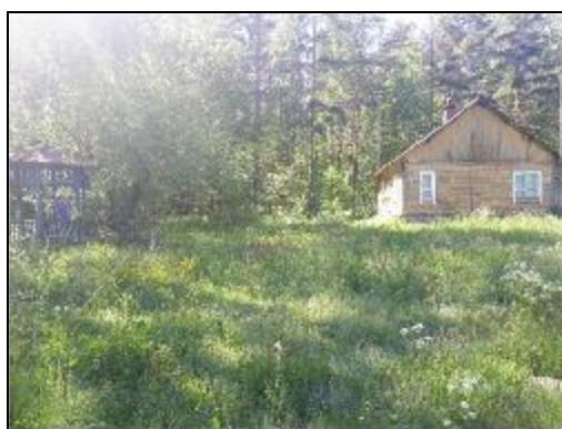
Фото 66. Общий вид территории, дом охраны
