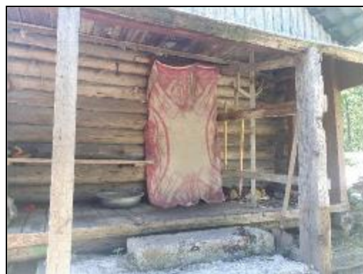
Фото 30. Вход в баню
