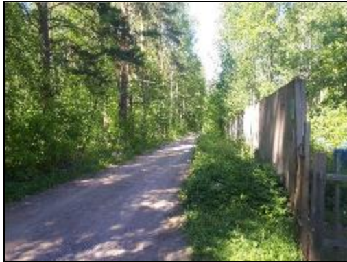
Фото 7. Подземная грунтовая дорога со стороны Приморского шоссе, бетонное ограждение
