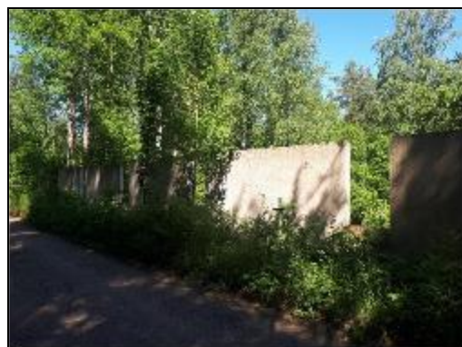
Фото 2. Бетонное ограждение части территории со стороны въезда
