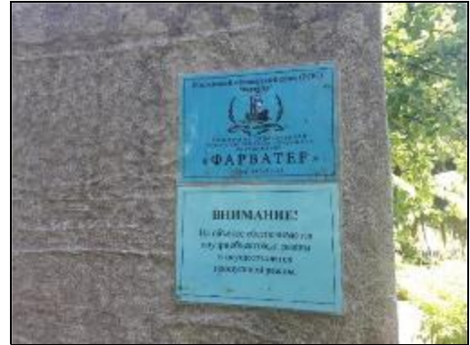
Фото 8. Бетонное ограждение части территории со стороны въезда (объект охраняется)
