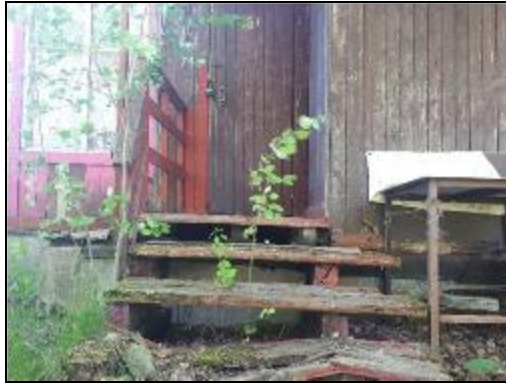
Фото 106. Общее состояние деревянных построек на участке
