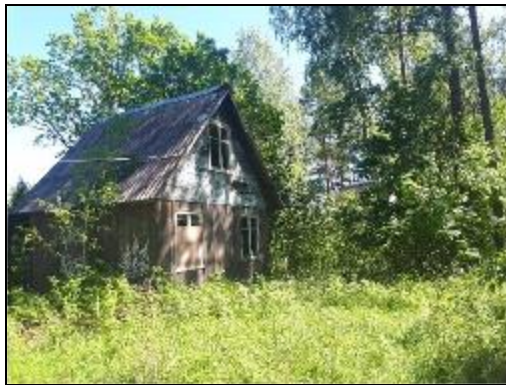
Фото 96. Общее состояние деревянных построек на участке
