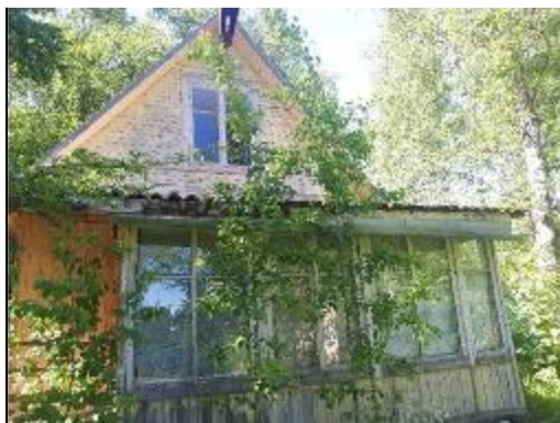
Фото 100. Общее состояние деревянных построек на участке
