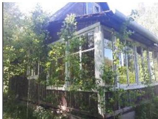
Фото 101. Общее состояние деревянных построек на участке
