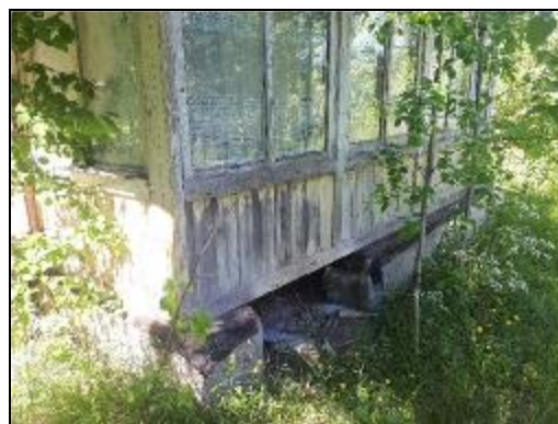
Фото 99. Общее состояние деревянных построек на участке
