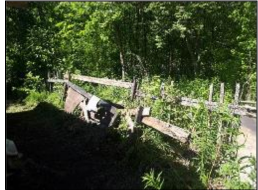
Фото 40. Ограждение территории со стороны залива (восточная граница участка)
