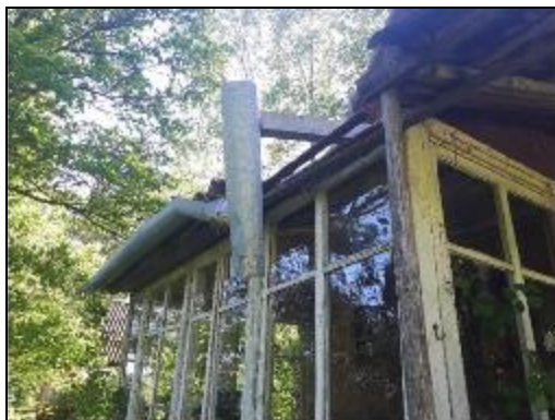
Фото 104. Общее состояние деревянных построек на участке
