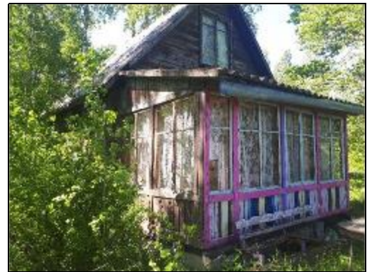
Фото 109. Общее состояние деревянных построек на участке
