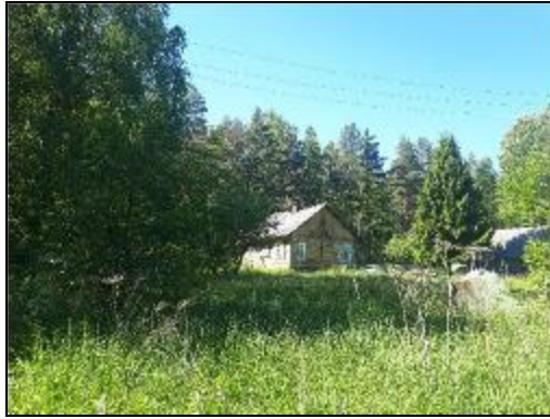
Фото 5. Общий вид территории, дом охраны
