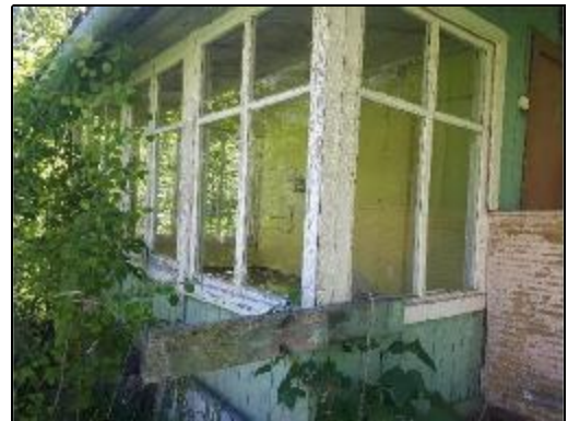
Фото 95. Общее состояние деревянных построек на участке
