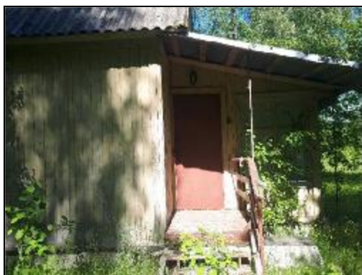
Фото 98. Общее состояние деревянных построек на участке
