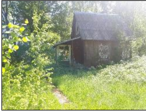
Фото 90. Общее состояние деревянных построек на участке
