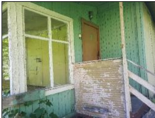
Фото 94. Общее состояние деревянных построек на участке
