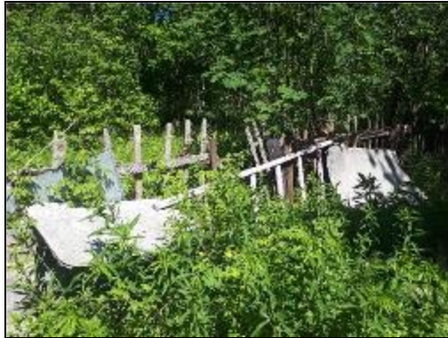
Фото 39. Ограждение территории со стороны залива (восточная граница участка)
