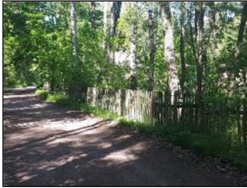
Фото 138. Подъездная грунтовая дорога со стороны Приморского шоссе, ограждение (юго-западная граница участка)
