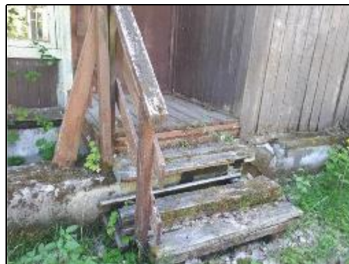
Фото 103. Общее состояние деревянных построек на участке
