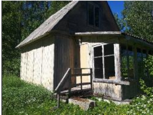
Фото 92. Общее состояние деревянных построек на участке
