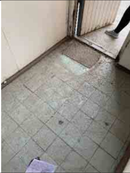
Фото №13 Состояние пола
