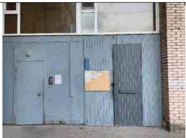
Фото №2 Главный вход в здание
