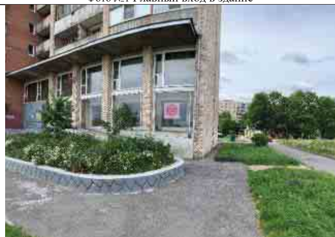
Фото №3 Вид помещения с улицы
