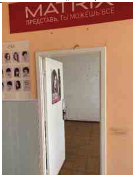
Фото №16 Вход в помещении
