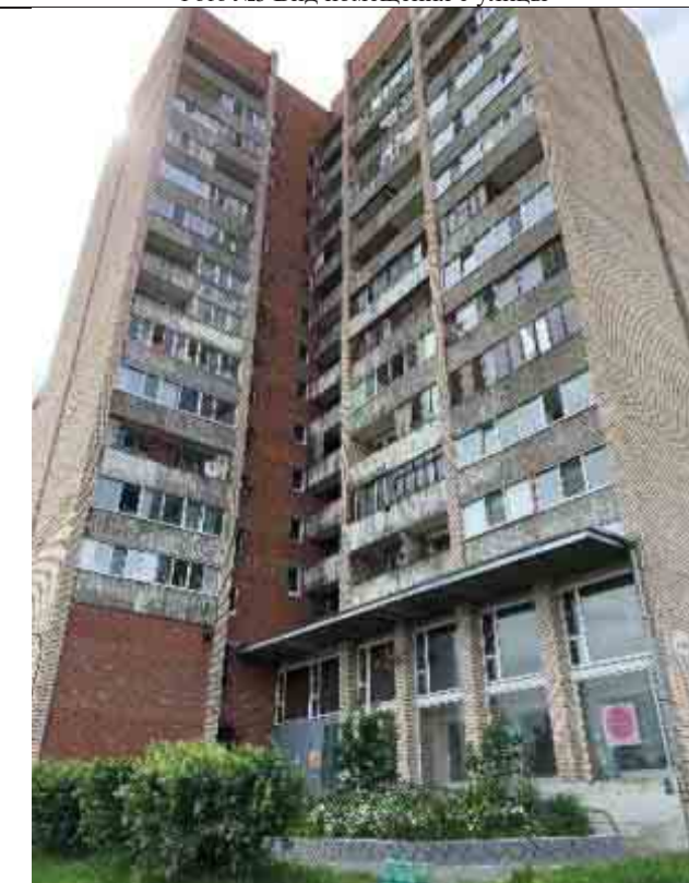
Фото №5 Вид здания
