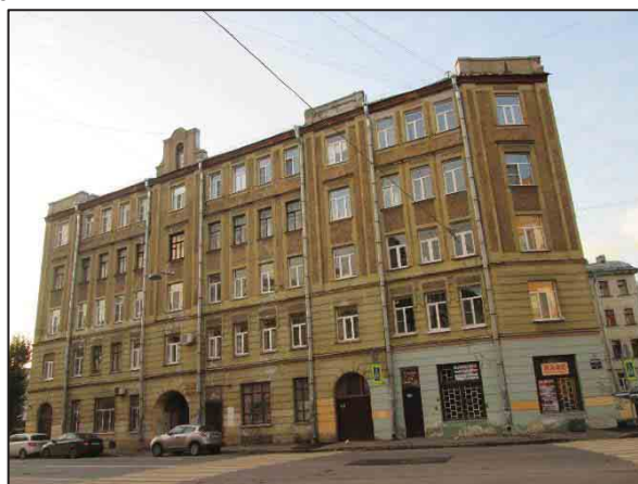
Фото 2. Вид здания, в котором расположен Объект оценки, с улицы, ближайшее окружение
