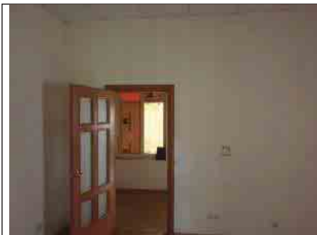
Фото №19: Внутренняя отделка
