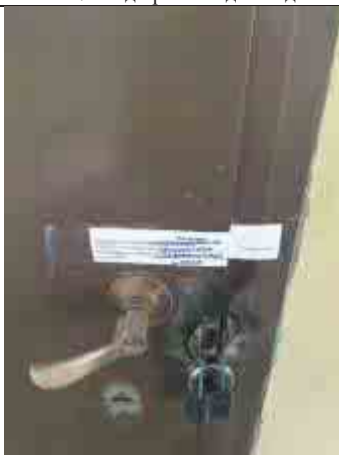
Фото №9: Входная дверь.
