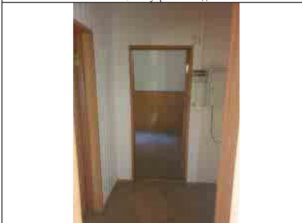
Фото №21: Внутренняя отделка
