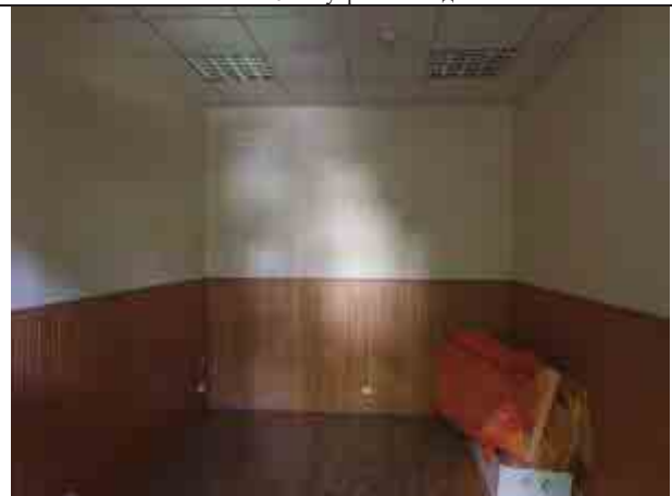
Фото №22: Внутренняя отделка
