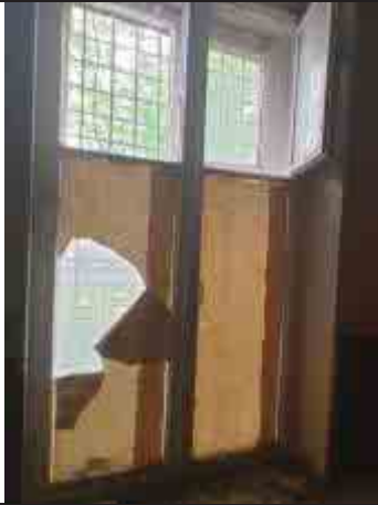
Фото №13: Состояние окон.
