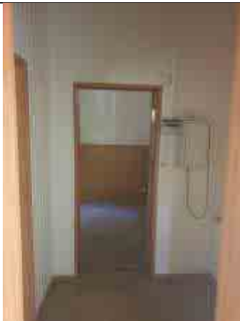
Фото №15: Состояние дверных проемов.
