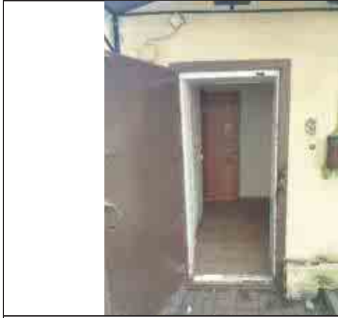
Фото №11: Входная дверь.
