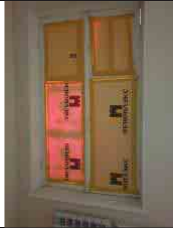
Фото №14: Состояние окон.
