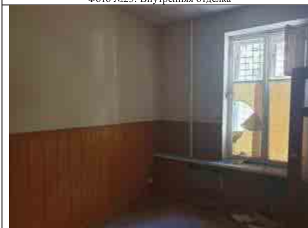
Фото №25: Внутренняя отделка
