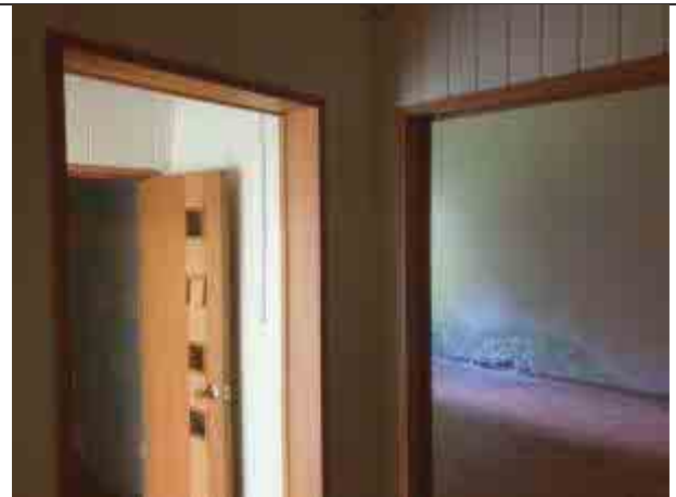
Фото №16: Состояние дверных проемов.
