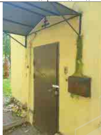
Фото №10: Входная дверь.
