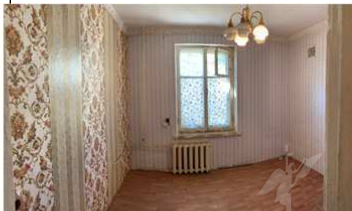
Фото №18. Внутренняя отделка
