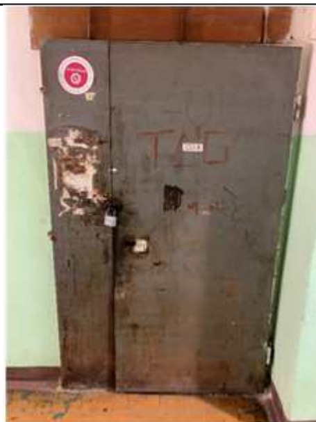
Фото №8. Вход в помещение
