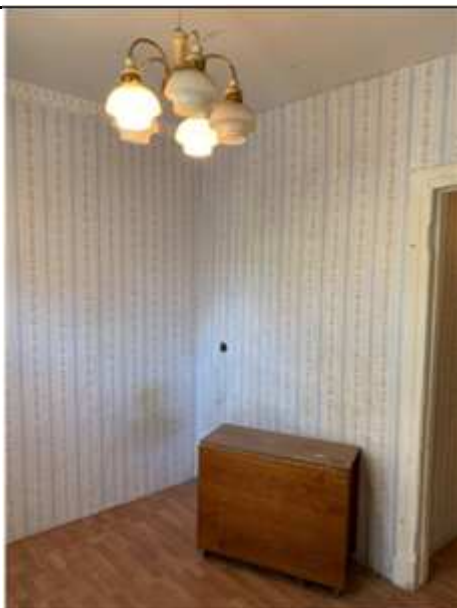
Фото №17. Внутренняя отделка
