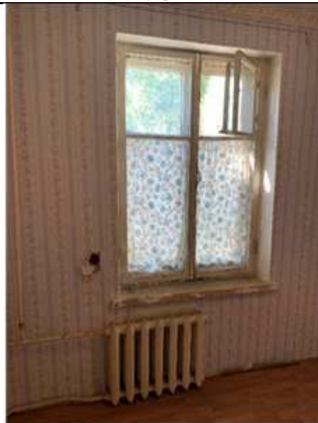
Фото №16 Состояние окон
