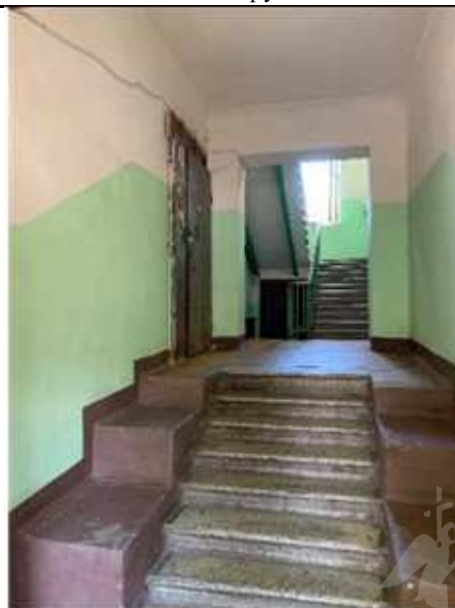
Фото №6 Лестничная площадка
