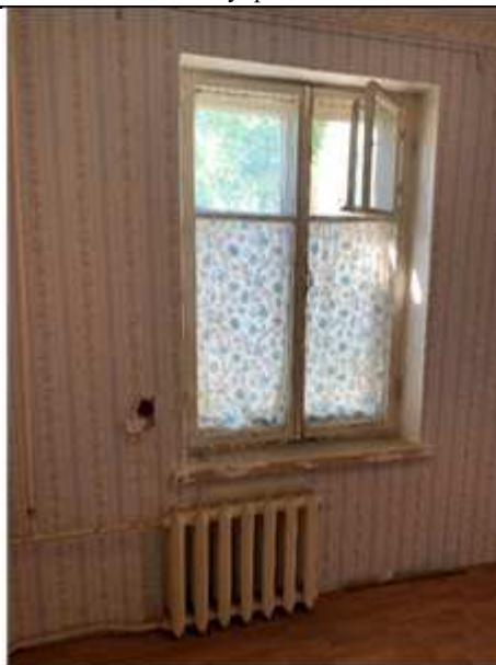
Фото №16 Состояние окон
