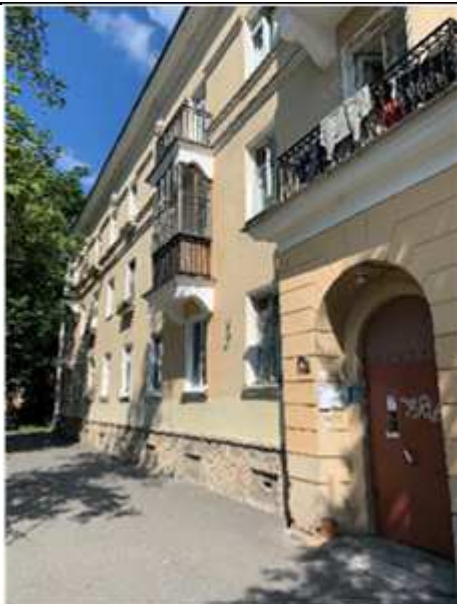
Фото №1 Главный вход в здание
