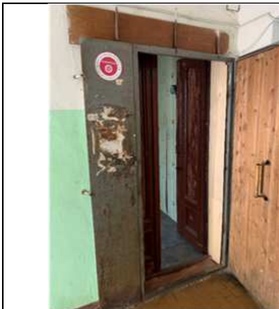
Фото №7 Вход в помещение
