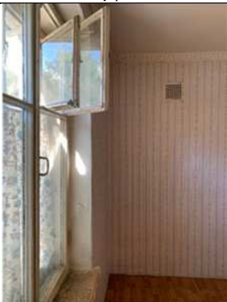
Фото №15 Состояние окон
