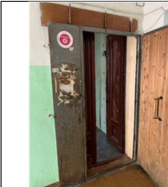
Фото №7 Вход в помещение
