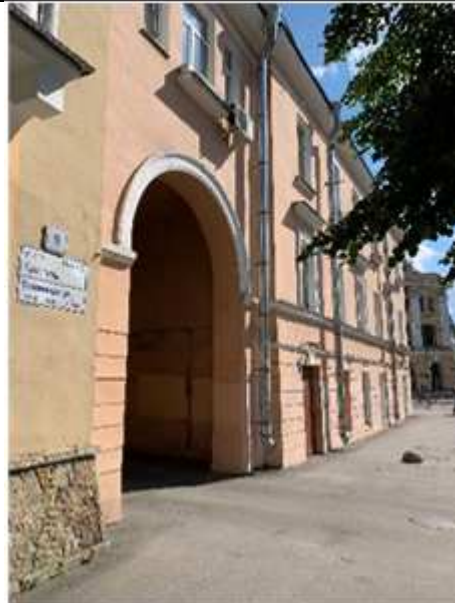
Фото №2 Вид здания
