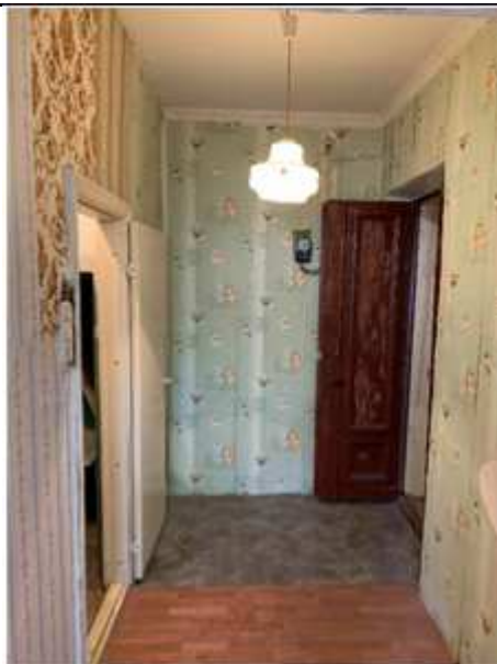
Фото №14 Внутренняя отделка
