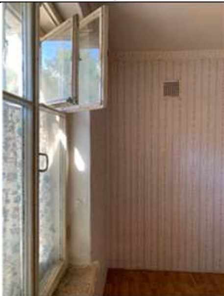
Фото №15 Состояние окон
