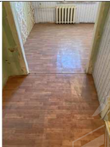
Фото №12 Состояние пола
