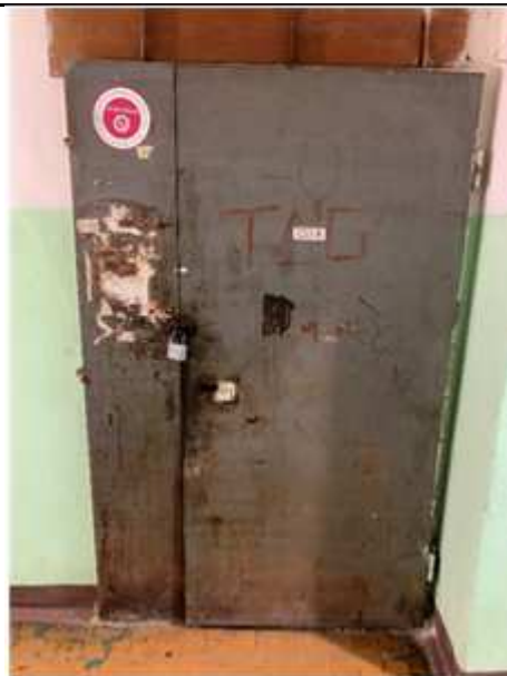
Фото №8. Вход в помещение
