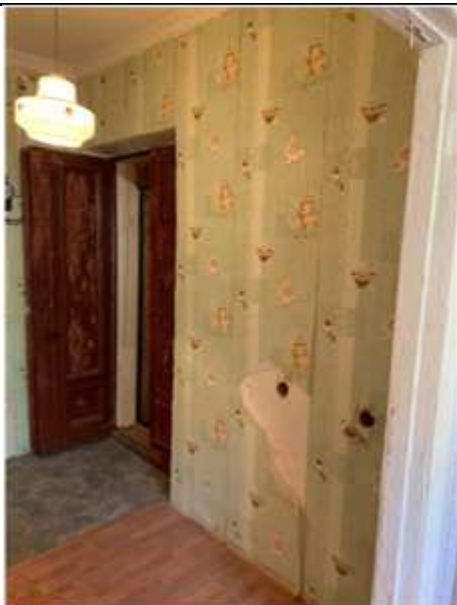
Фото №13 Внутренняя отделка
