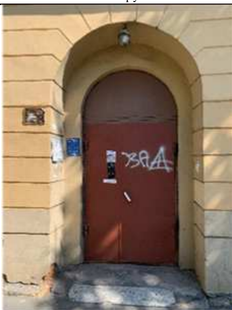
Фото №5 Главный вход в здание
