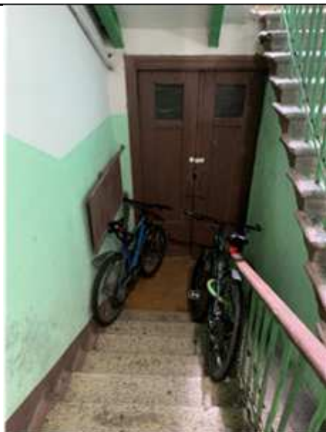
Фото №9 Лестничная площадка
