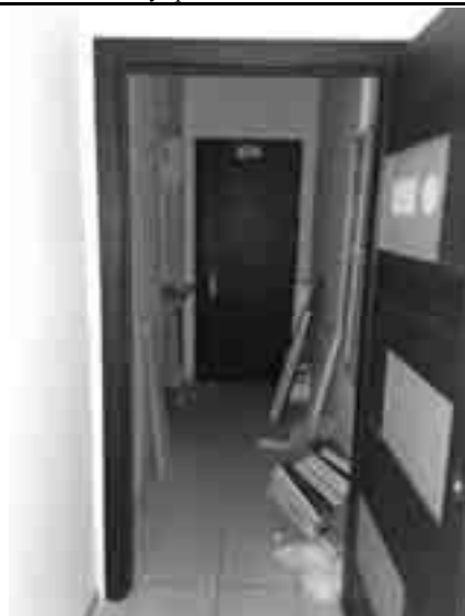
Фото № 32. Внутреннее состояние помещения
