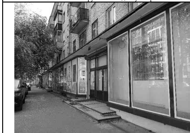
Фото № 7. Внешний вид Объекта оценки. Вход в помещение
