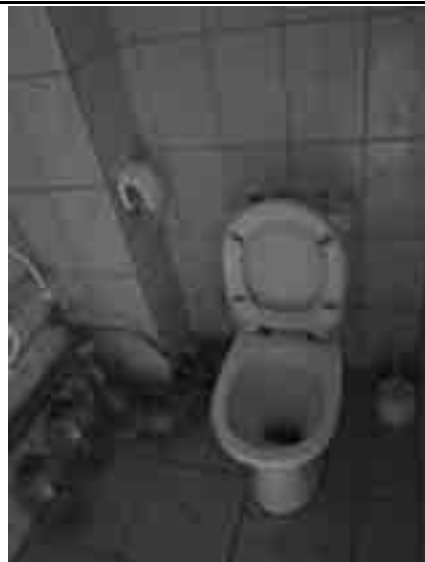
Фото № 30. Внутреннее состояние помещения
