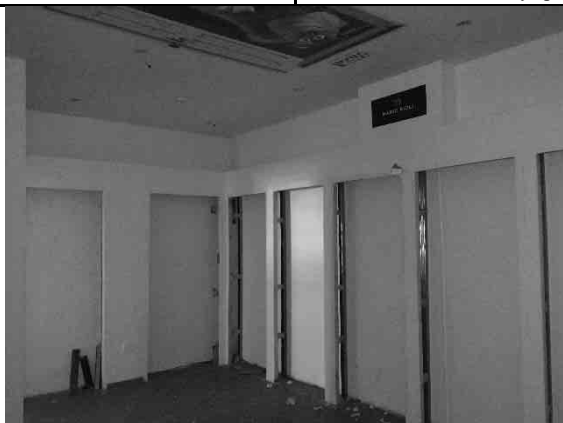
Фото № 33. Внутреннее состояние помещения
