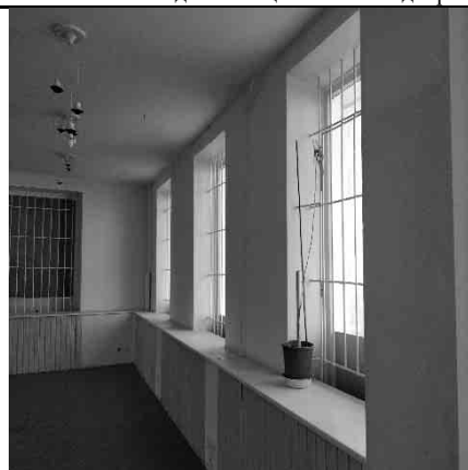
Фото № 14. Внутреннее состояние помещения
