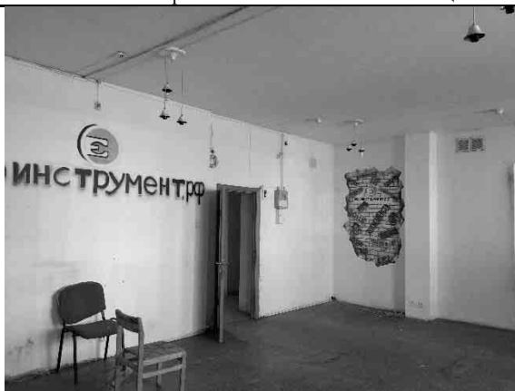
Фото № 13. Внутреннее состояние помещения
