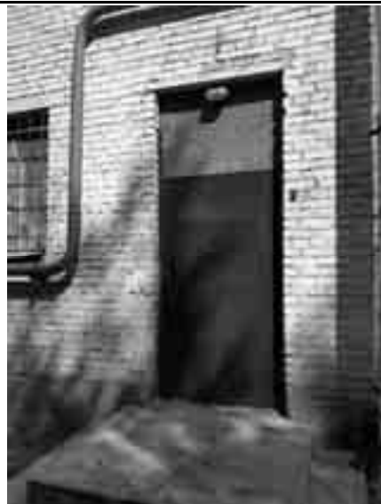
Фото № 12. Вход в помещение 1-Н со двора
