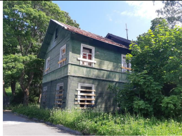
Фото 9. Вид на здание размещения Объекта оценки.
