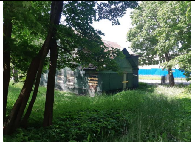
Фото 4. Вид на здание размещения Объекта оценки.
