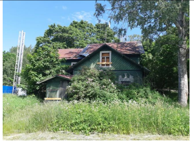
Фото 8. Вид на здание размещения Объекта оценки.
