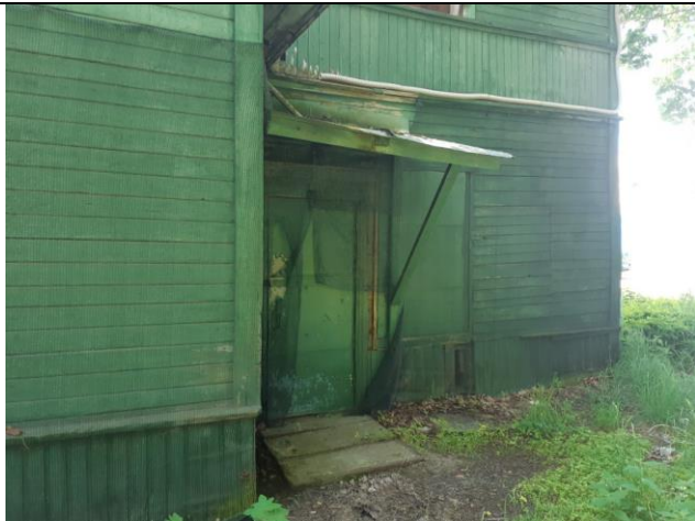
Фото 5. Вид на здание размещения Объекта оценки.
