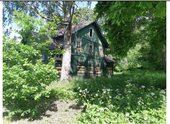
Фото 2. Вид на здание размещения Объекта оценки.
