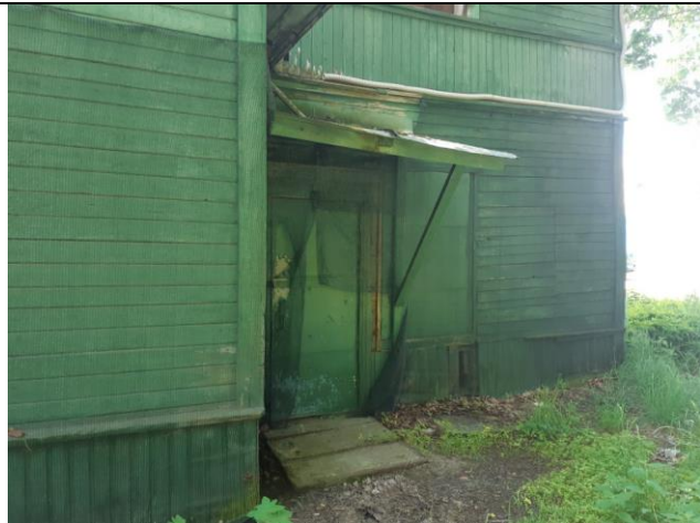
Фото 5. Вид на здание размещения Объекта оценки.
