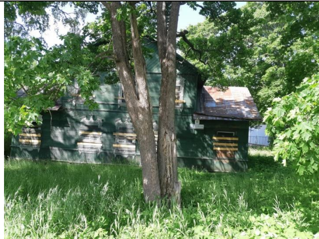
Фото 3. Вид на здание размещения Объекта оценки.
