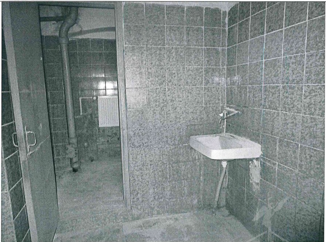
Описание: Вид внутри Объекта
