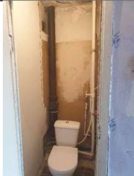
Фото №8: Вид помещения. Сан. узел
