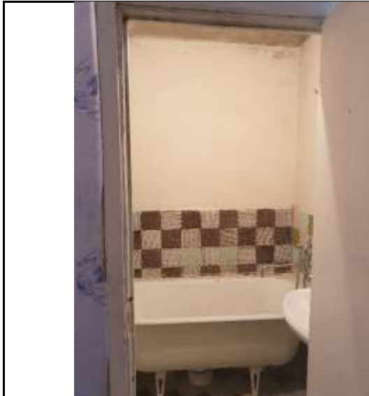
Фото №7: Вид помещения. Сан. узел
