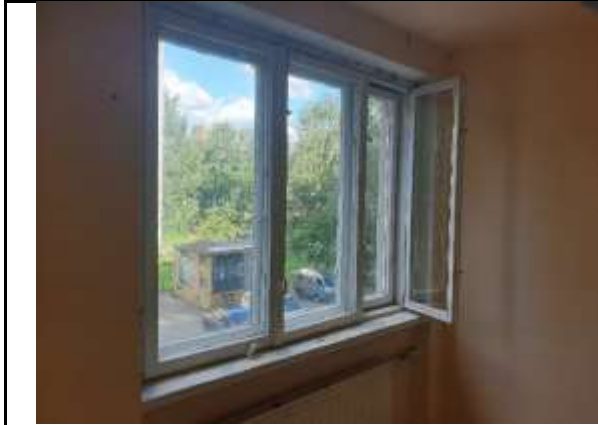
Фото №13: Состояние помещения. Оконный проем.
