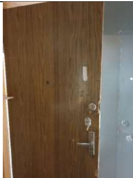
Фото №2: Вход в помещение 6-Н. Дверь
