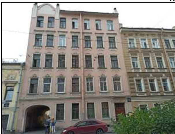
Фото 1. Вид здания, в котором расположен Объект оценки, с Верейской ул.
