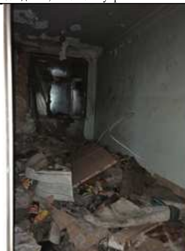
Фото № 22. Здание, лит. А. Внутреннее состояние. 2-этаж
