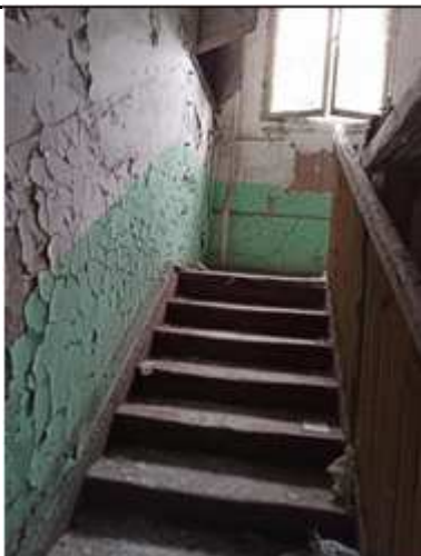
Фото № 19. Здание, лит. А. Внутреннее состояние
