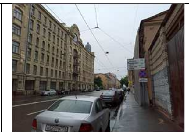
Фото № 2. Внешнее окружение Объекта
