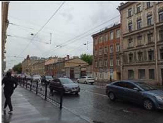
Фото №31: Внешний вид здания лит. А
