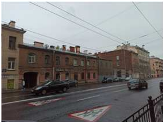
Фото №33: Внешний вид здания лит. А
