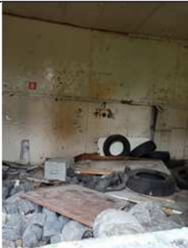
Фото № 27. Здание, лит. А. Внутреннее состояние. 1 этаж
