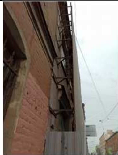
Фото №34: Внешний вид здания лит. А. Фасад
