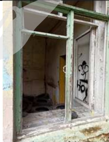
Фото № 28. Здание, лит. А. Внутреннее состояние. 1 этаж
