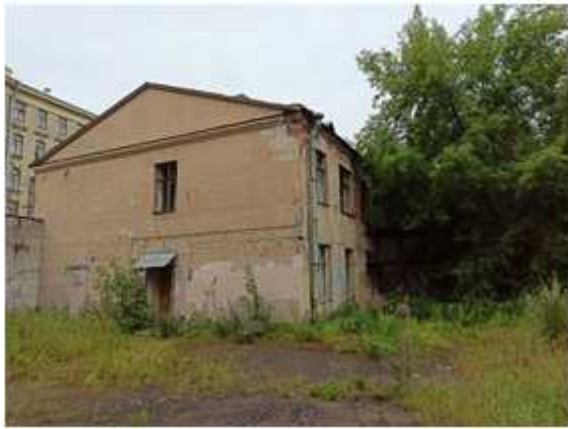
Фото № 5. Здание, лит. А
