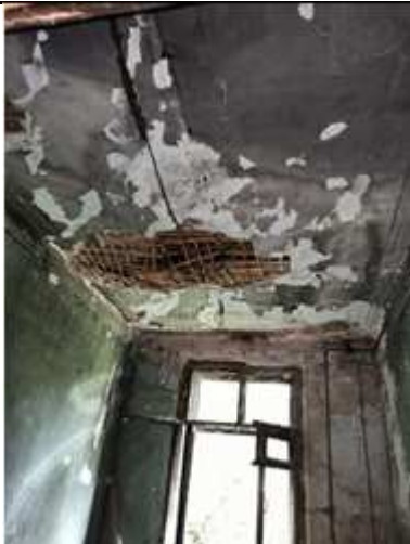
Фото № 21. Здание, лит. А. Внутреннее состояние. 2 этаж
