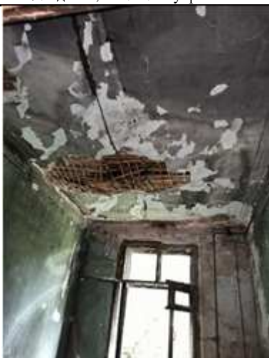
Фото № 21. Здание, лит. А. Внутреннее состояние. 2 этаж
