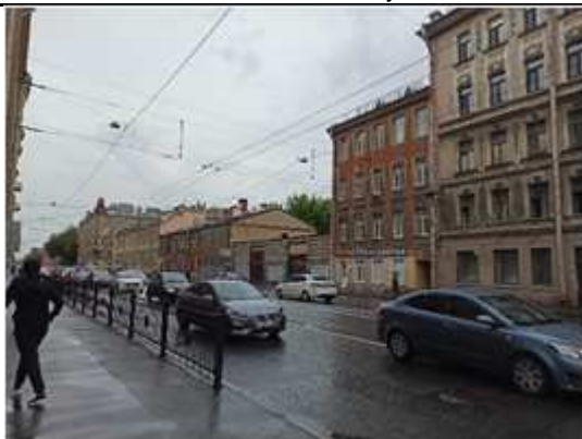
Фото №31: Внешний вид здания лит. А
