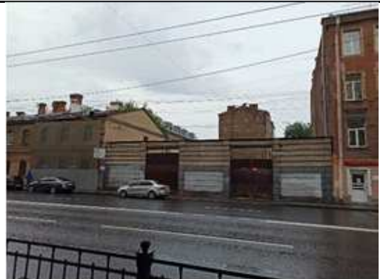
Фото № 32: Внешний вид здания лит. А
