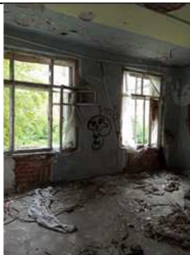
Фото № 20. Здание, лит. А. Внутреннее состояние. 2 этаж
