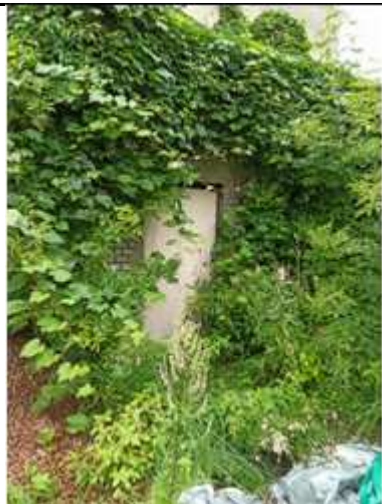
Фото № 8. Здание, лит. В. Вход 1
