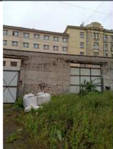
Фото №30: Захламление участка
