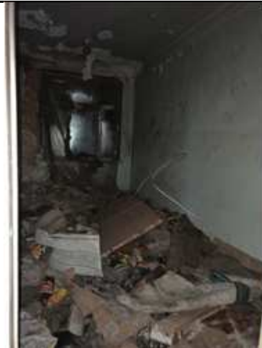
Фото № 22. Здание, лит. А. Внутреннее состояние. 2-этаж
