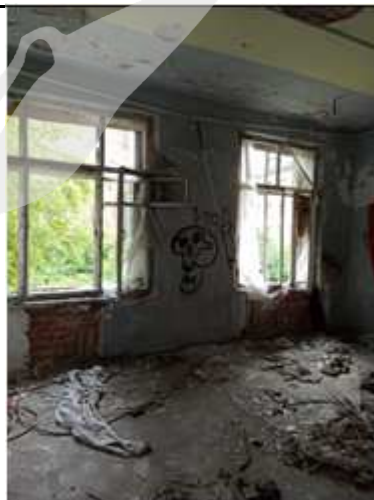
Фото № 20. Здание, лит. А. Внутреннее состояние. 2 этаж
