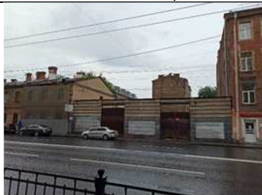
Фото № 32: Внешний вид здания лит. А
