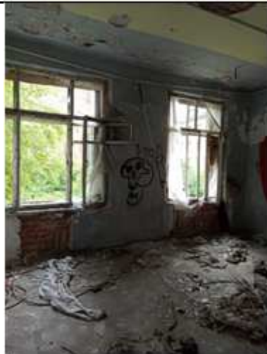
Фото № 20. Здание, лит. А. Внутреннее состояние. 2 этаж
