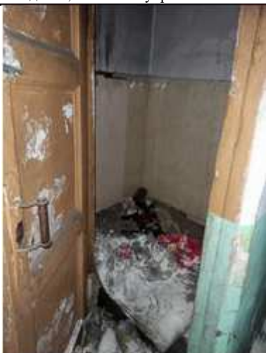
Фото № 23. Здание, лит. А. Внутреннее состояние. 2 этаж
