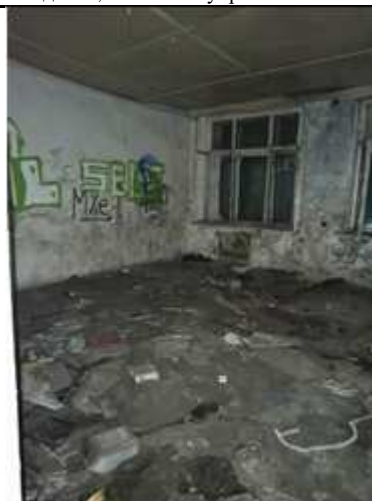
Фото № 24. Здание, лит. А. Внутреннее состояние. 2 этаж
