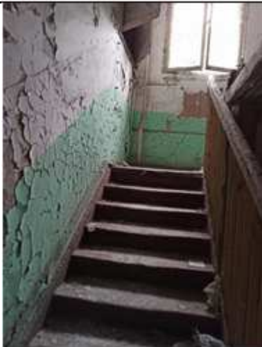
Фото № 19. Здание, лит. А. Внутреннее состояние
