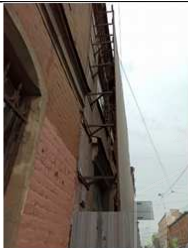
Фото №34: Внешний вид здания лит. А. Фасад
