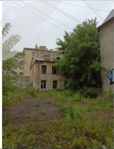
Фото № 6. Здание, лит. А
