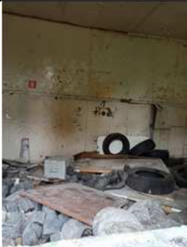
Фото № 27. Здание, лит. А. Внутреннее состояние. 1 этаж
