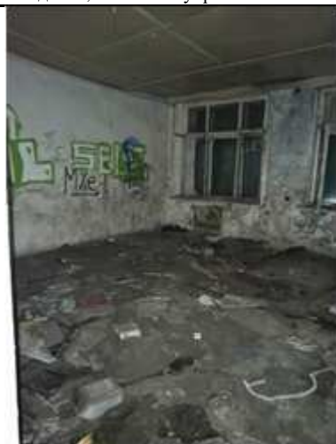
Фото № 24. Здание, лит. А. Внутреннее состояние. 2 этаж
