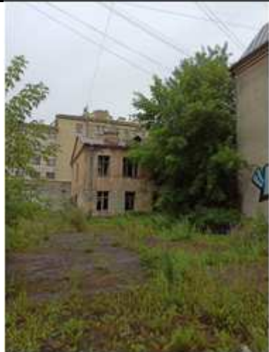
Фото № 6. Здание, лит. А
