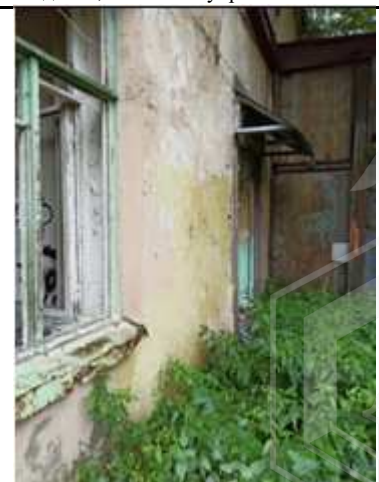
Фото № 26. Здание, лит. А. Вход № 2
