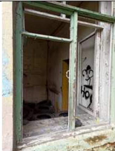
Фото № 28. Здание, лит. А. Внутреннее состояние. 1 этаж
