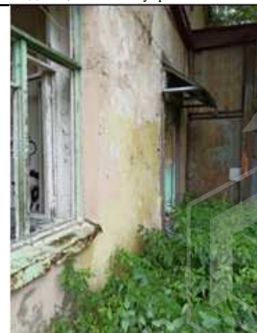
Фото № 26. Здание, лит. А. Вход № 2
