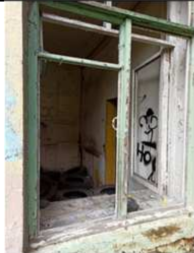
Фото № 28. Здание, лит. А. Внутреннее состояние. 1 этаж
