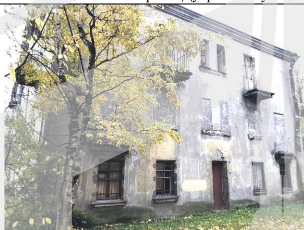
Фото 3. Вид на фасад здания расположения Объекта оценки со двора
