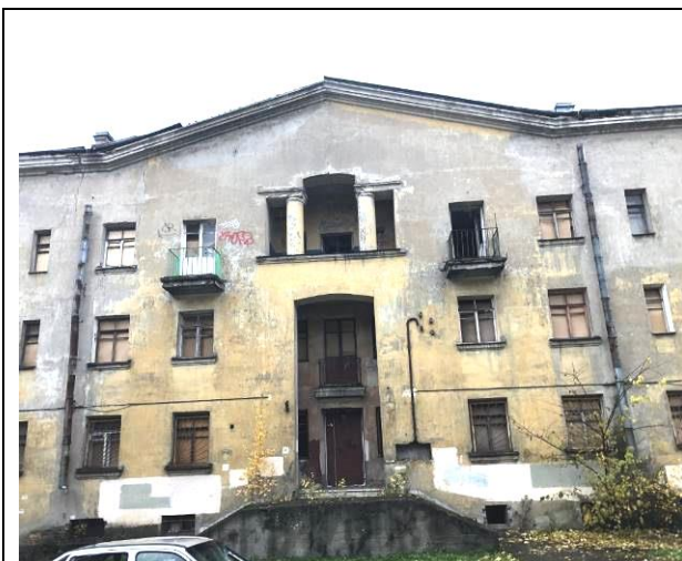
Фото 1. Вид на фасад здания расположения Объекта оценки со стороны Дубровской улицы
