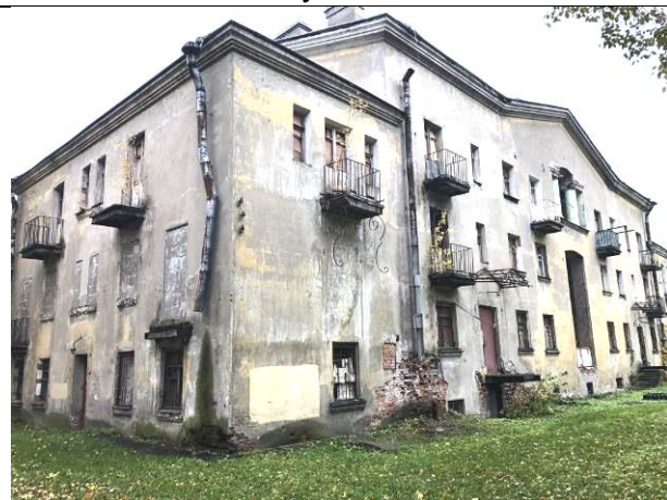
Фото 4. Вид на фасад здания расположения Объекта оценки. Дворовая территория
