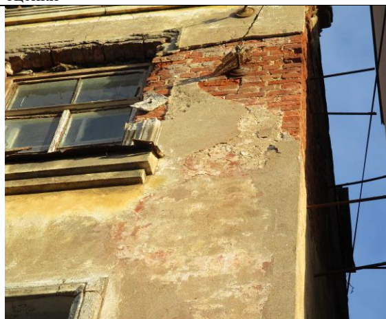
Фото 12. Вид здания, в котором расположен объект оценки
