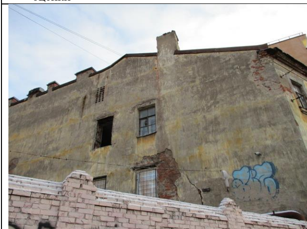
Фото 7. Вид здания, в котором расположен объект оценки
