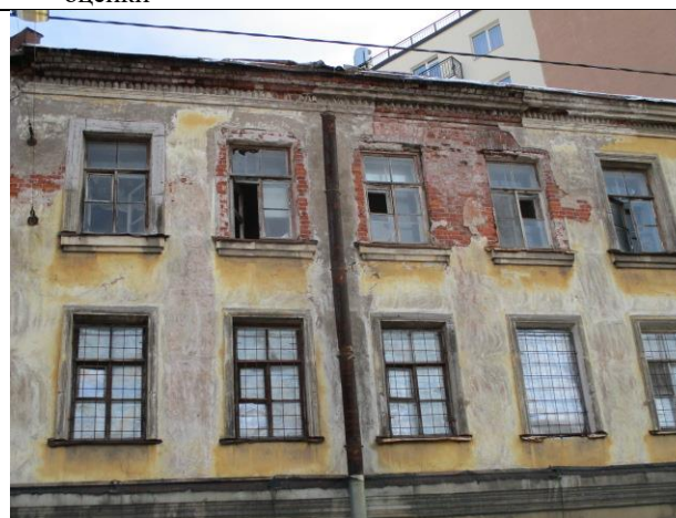
Фото 6. Вид здания, в котором расположен объект оценки
