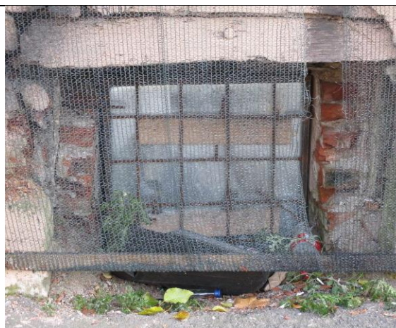
Фото 10. Вид здания, в котором расположен объект оценки
