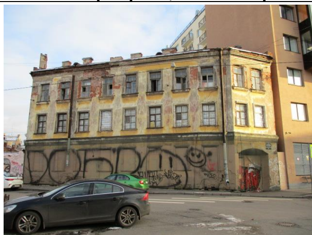
Фото 1. Вид здания, в котором расположен объект оценки
