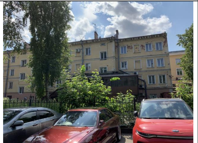
Фото 6. Дворовая территория, ближайшее окружение.
