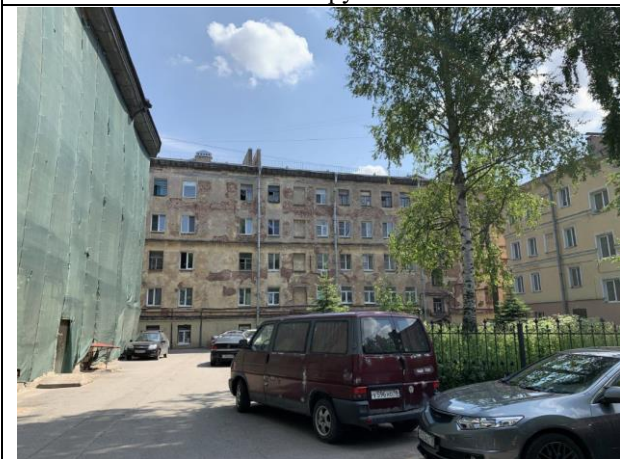
Фото 7. Дворовая территория, ближайшее окружение.
