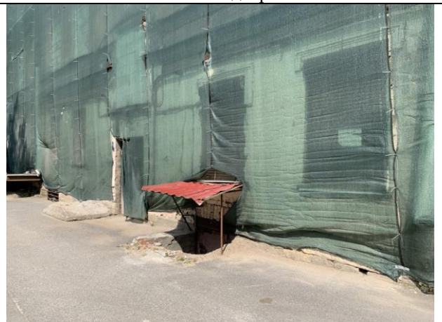
Фото 14. Входы со двора
