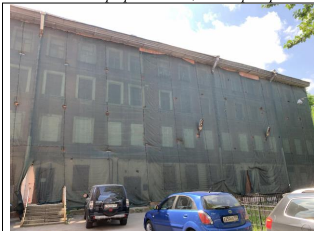
Фото 1. Вид на здание расположения Объекта оценки.
