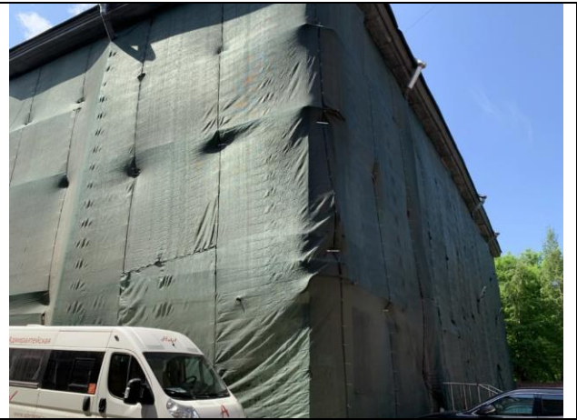
Фото 4. Вид на здание расположения Объекта оценки.
