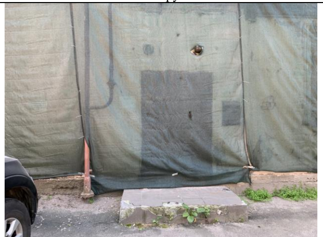
Фото 12. Отдельный вход в пом. 16-Н со двора
