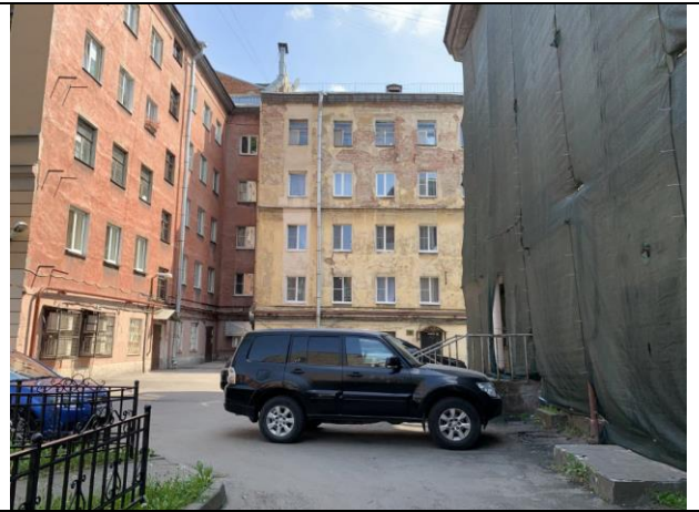
Фото 10. Дворовая территория, ближайшее окружение.
