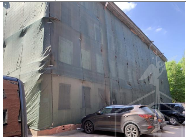
Фото 2. Вид на здание расположения Объекта оценки.
