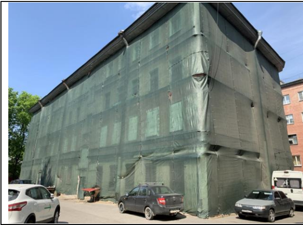
Фото 3. Вид на здание расположения Объекта оценки.
