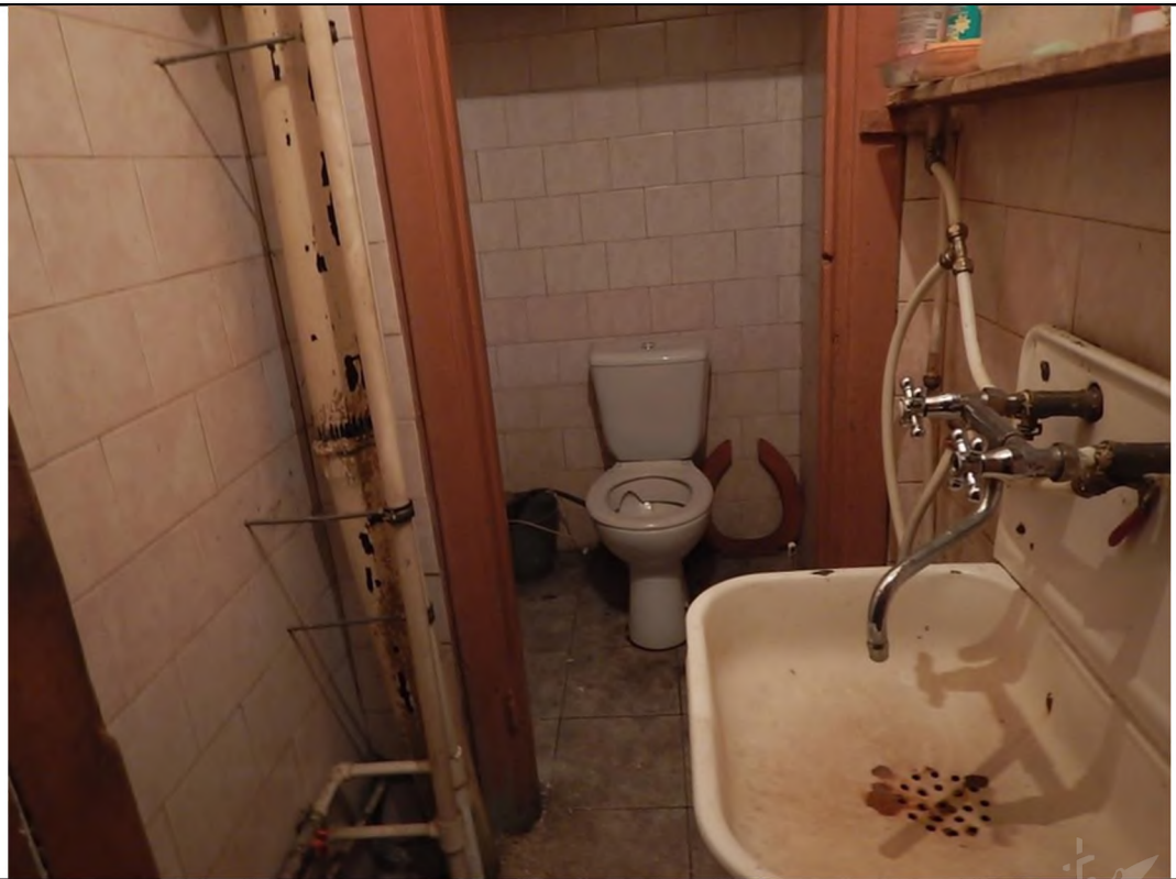
Описание: Вид в ч.п. 5 и 6 Объекта.
