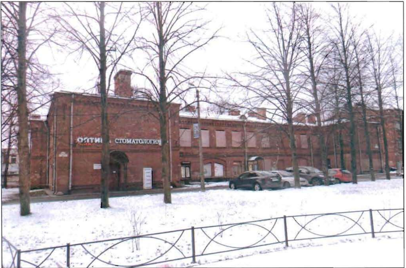
1. Общий вид с северо-востока.
