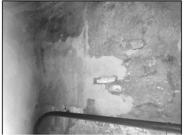
Фото 11. Отдельный вход 2 со двора – заложен кирпичом, отсутствует
