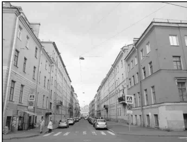
Фото 7. Ближайшее окружение вдоль Средней Подъяческой ул. Характеристика входной группы в помещение и оконных проемов
