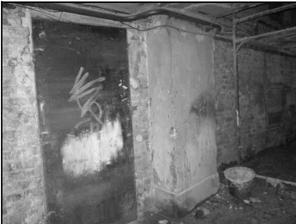
Фото 10. Отдельный вход 1 со двора (2-й двор-колодец)
