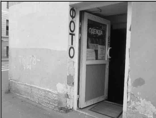
Фото 5. Объекты локального окружения (коммерческие помещения) цокольного этажа родительского объекта оцениваемого помещения
