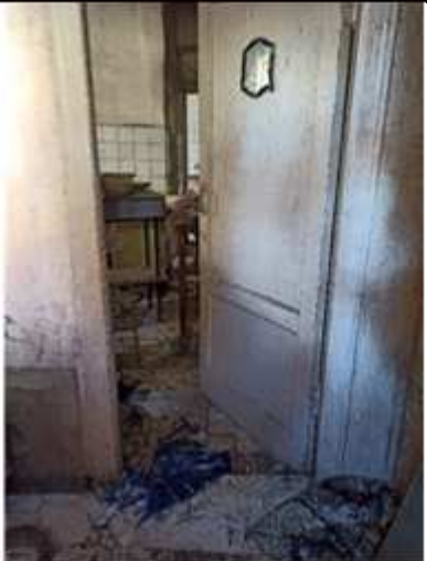
Фото №7: Внутреннее состояние
