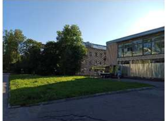
Фото №16: Внешнее окружение.
