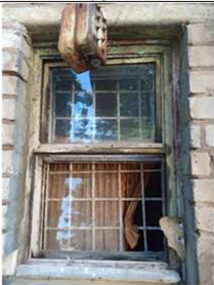
Фото №9: Оконный проем
