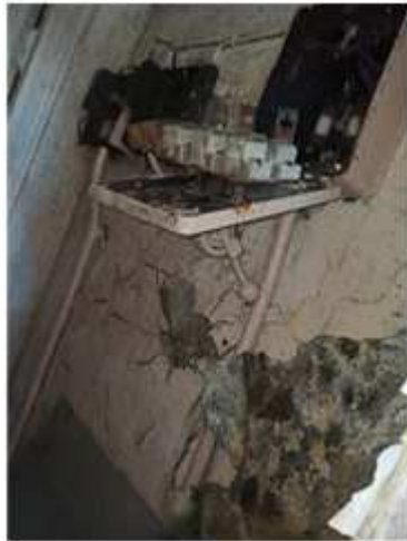
Фото №8: Внутреннее состояние
