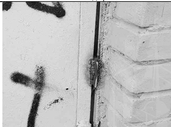
Фото №8. Заваренный дверной проем
