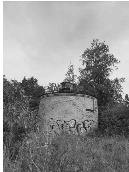
Фото №4: Вид дороги к здания с восточной стороны.
