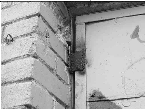
Фото №7. Заваренный дверной проем
