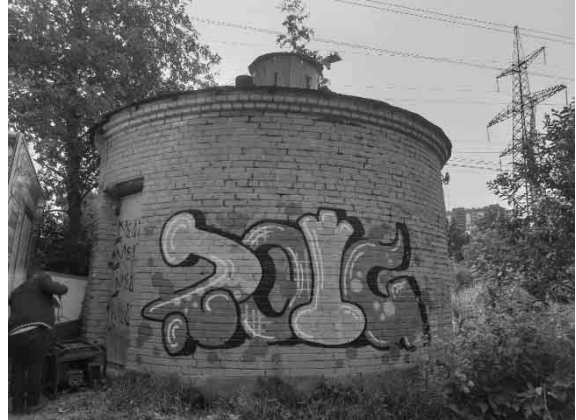
Фото №2. Внешний вид здания
