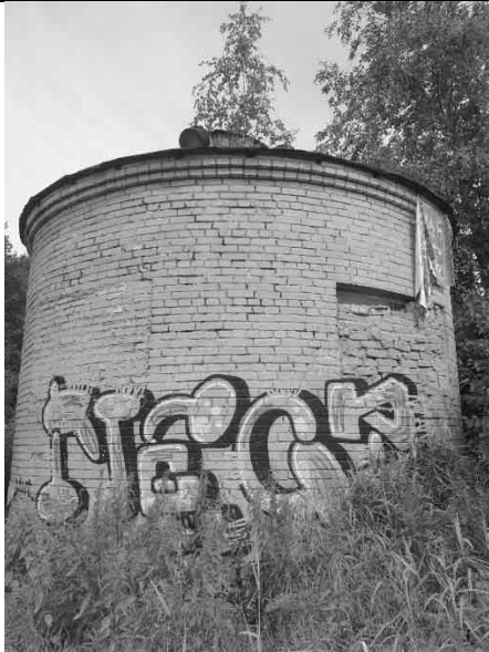
Фото №3: Внешний вид здания.
