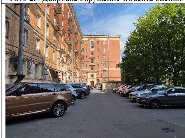
Фото 27. Дворовое окружение Объекта оценки.
