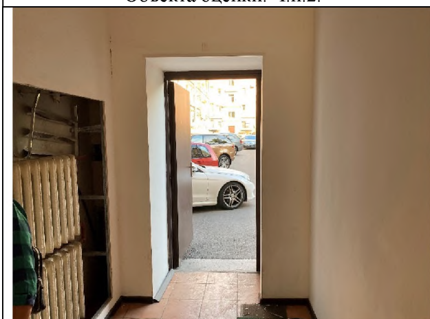
Фото 23. Состояние внутренней отделки Объекта оценки. Ч.п.3. Выход во двор.
