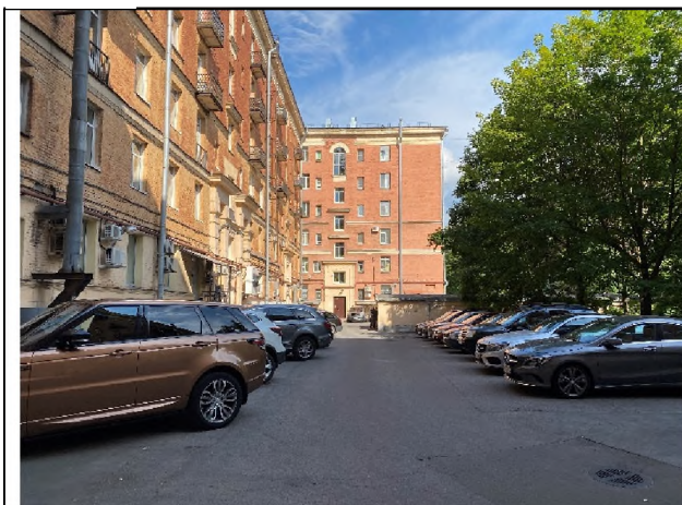
Фото 27. Дворовое окружение Объекта оценки.
