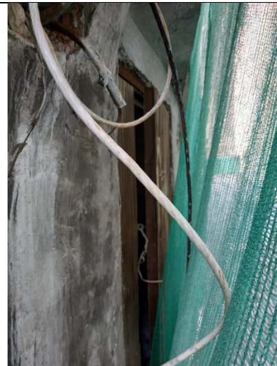
Фото 5. Оцениваемый объект недвижимости. Вход в здание
