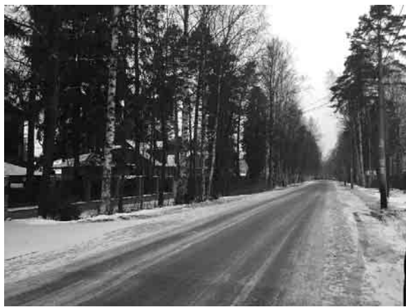
Фото 7. Вид подъездных путей
