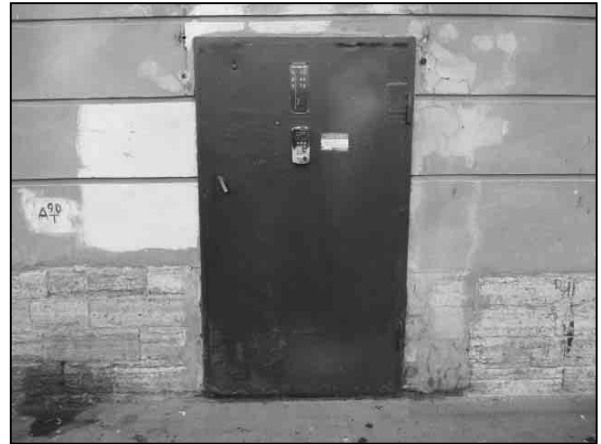
Фото 10. Общий вход с улицы
