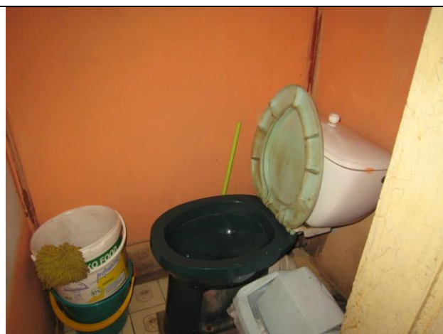
Фото 40 Вид части помещения № 8
