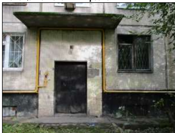
Фото 10. Общий вход со двора (пожарный выход)
