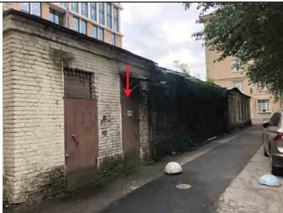
Фото 8. Здание, в котором расположен Объект оценки (вид со двора, входы в Объект оценки)
