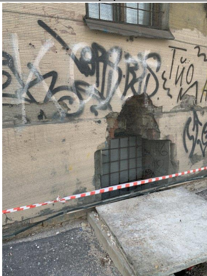
Фото 5. Вид здания, в котором расположен объект оценки
