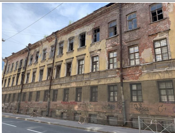
Фото 1. Вид здания, в котором расположен объект оценки
