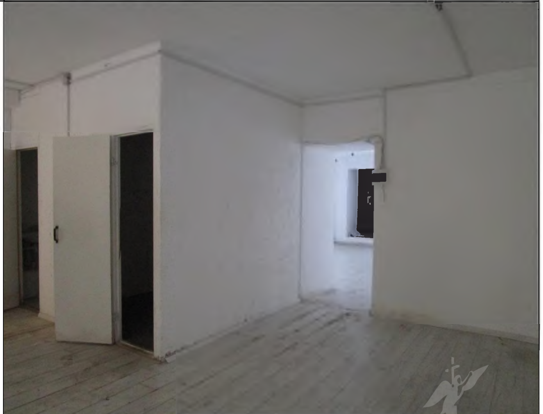
Описание: Вид внутри Объекта (в ч.п. 1 Объекта путем установки перегородки с двумя дверными проемами образованы два отдельных помещения)
