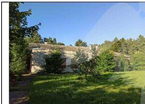
Фото №1: Внешний вид здания
