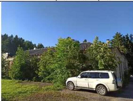
Фото №9: Окружение объекта
