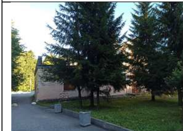
Фото №3: Внешний вид здания
