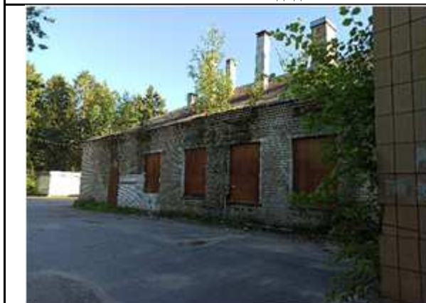
Фото №5: Внешний вид здания
