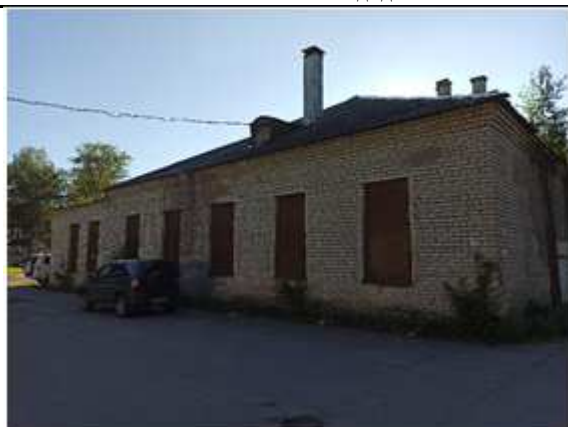
Фото №6: Внешний вид здания
