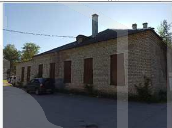
Фото №6: Внешний вид здания
