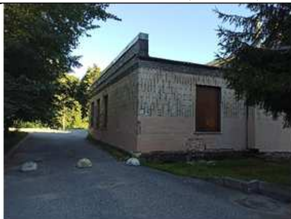
Фото №4: Внешний вид здания
