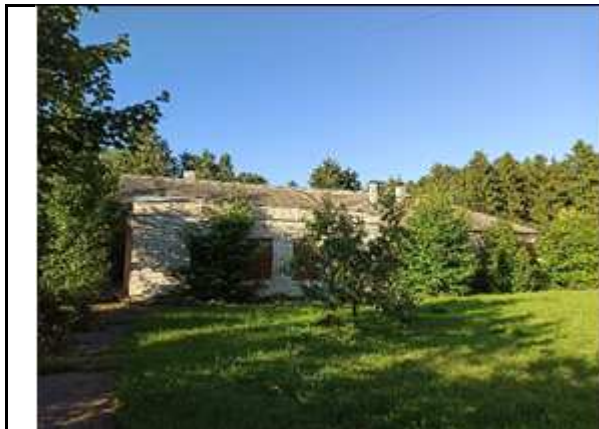
Фото №1: Внешний вид здания
