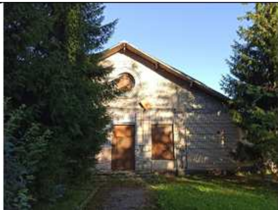
Фото №2: Внешний вид здания (главный вход)
