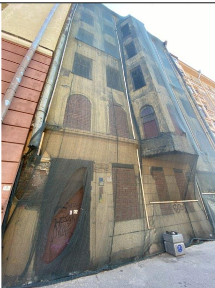
Фото 7. Вид на здание расположения Объекта оценки с Большой Разночинной ул.
