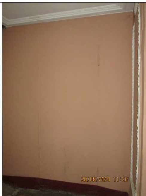
Фото 10. Вид заделанного входа в объект оценки с лестничной площадки.
