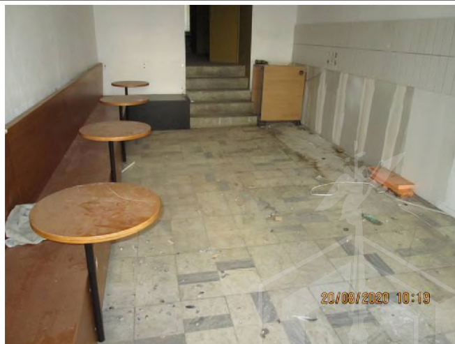
Фото 14. Состояние внутренней отделки в ч.п. 2.
