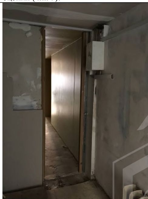
Фото 30. Состояние внутренней отделки объекта
