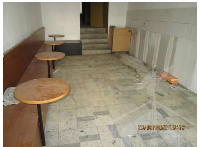
Фото 14. Состояние внутренней отделки в ч.п. 2.
