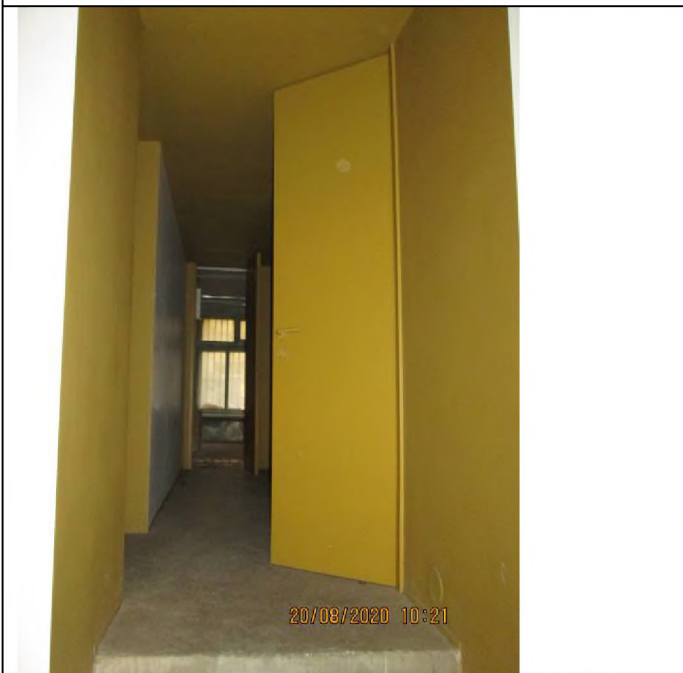
Фото 17. Состояние внутренней отделки в ч.п. 3.
