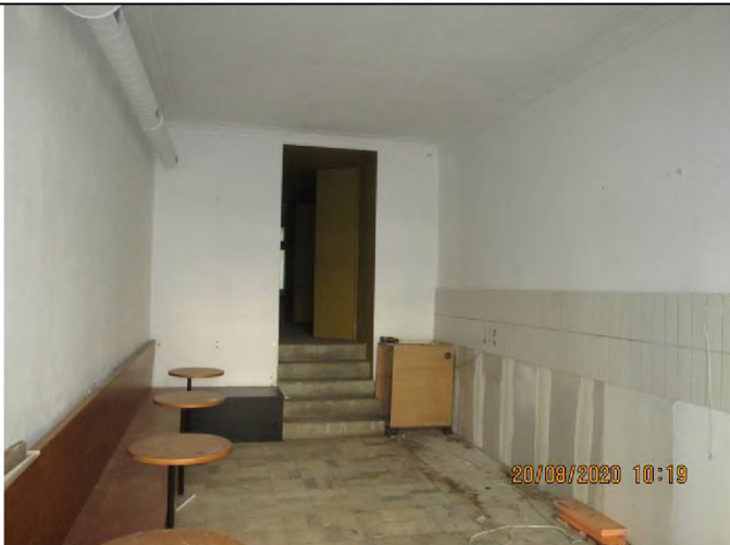
Фото 13. Состояние внутренней отделки в ч.п. 2.
