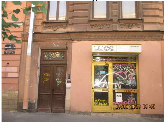
Фото 7. Отдельный вход в объект оценки и общий вход в объект оценки с улицы Маяковского
