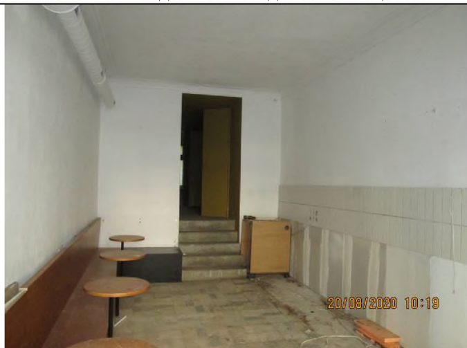
Фото 13. Состояние внутренней отделки в ч.п. 2.
