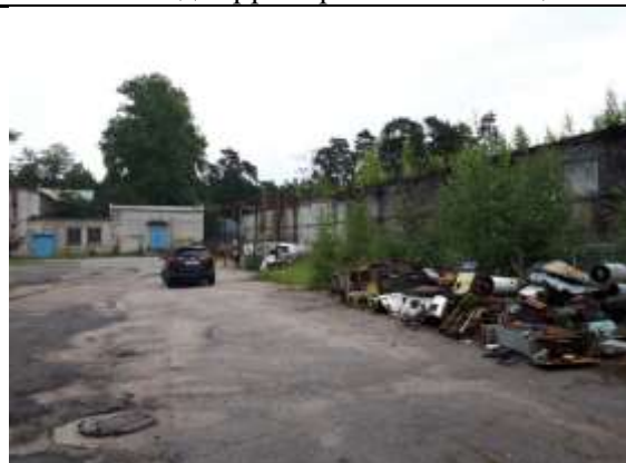
Фото 10. Ближайшее окружение, вид Объекта оценки
